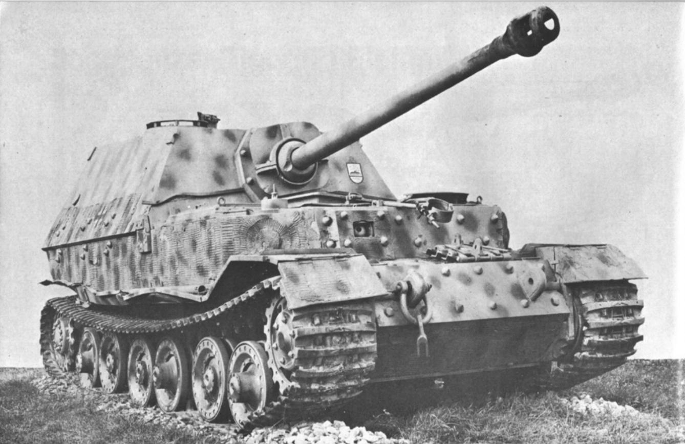
Ein Jagdpanzer "Elefant" ohne MG in der Kugelblende und noch mit teilweise Zimmeritbelag. Diese Panzer waren bis zu 200 mm gepanzert.
