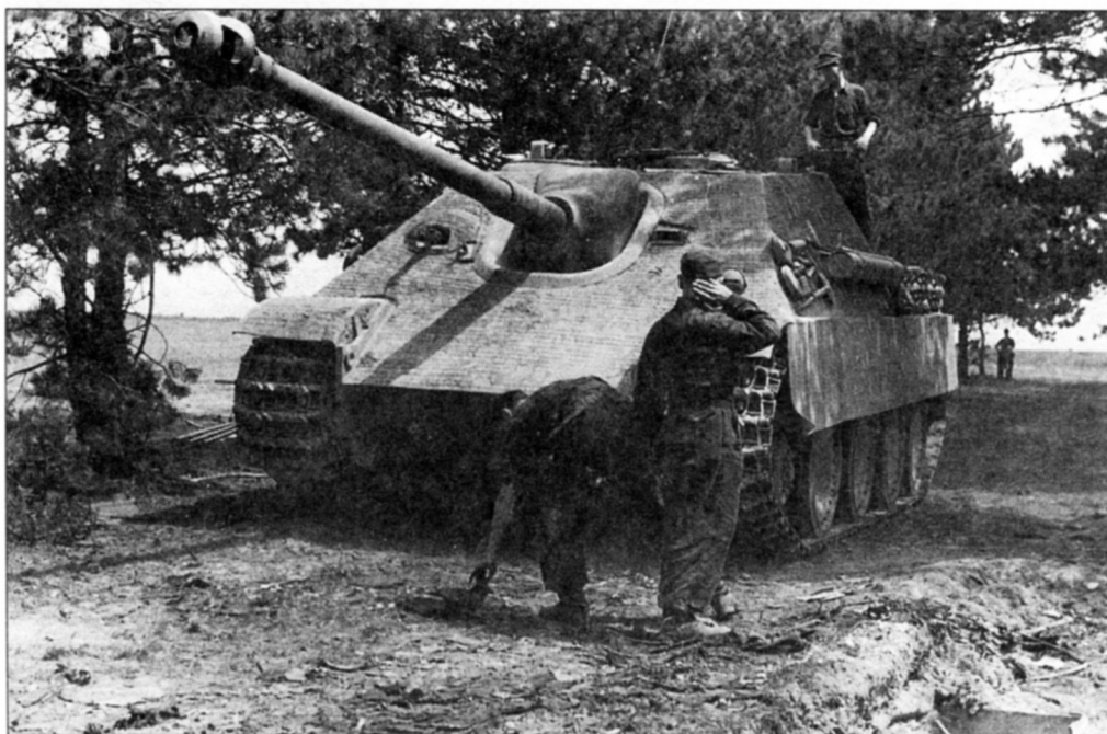
«Ягдпантера» с 88-мм пушкой, имеющей составной ствол. Франция, 1944 год
