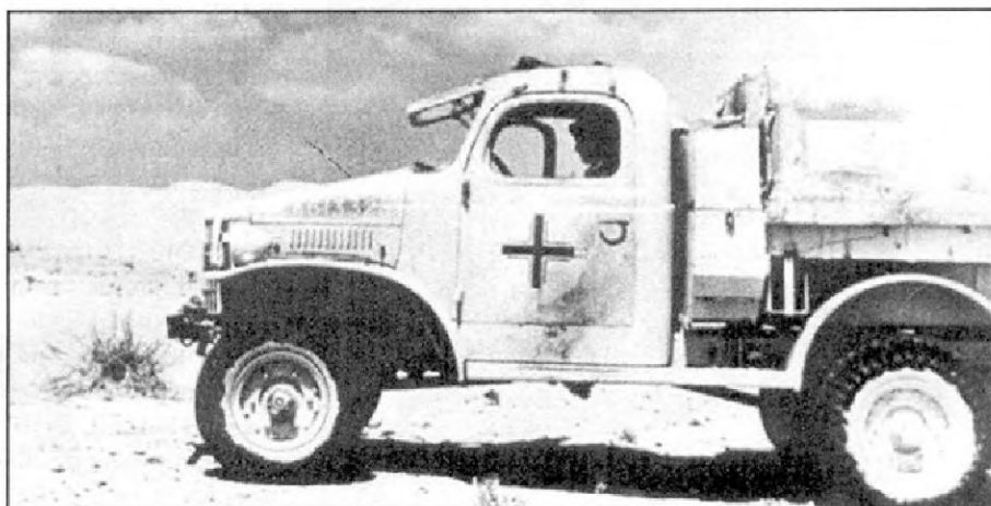
Трофейная радиомашинна на шасси канадского 1/2-тонного Dodge 4x4. Окрашена в цвета британского камуфляжа, на двери несколько нестандартный (тонкий) балочный крест.
