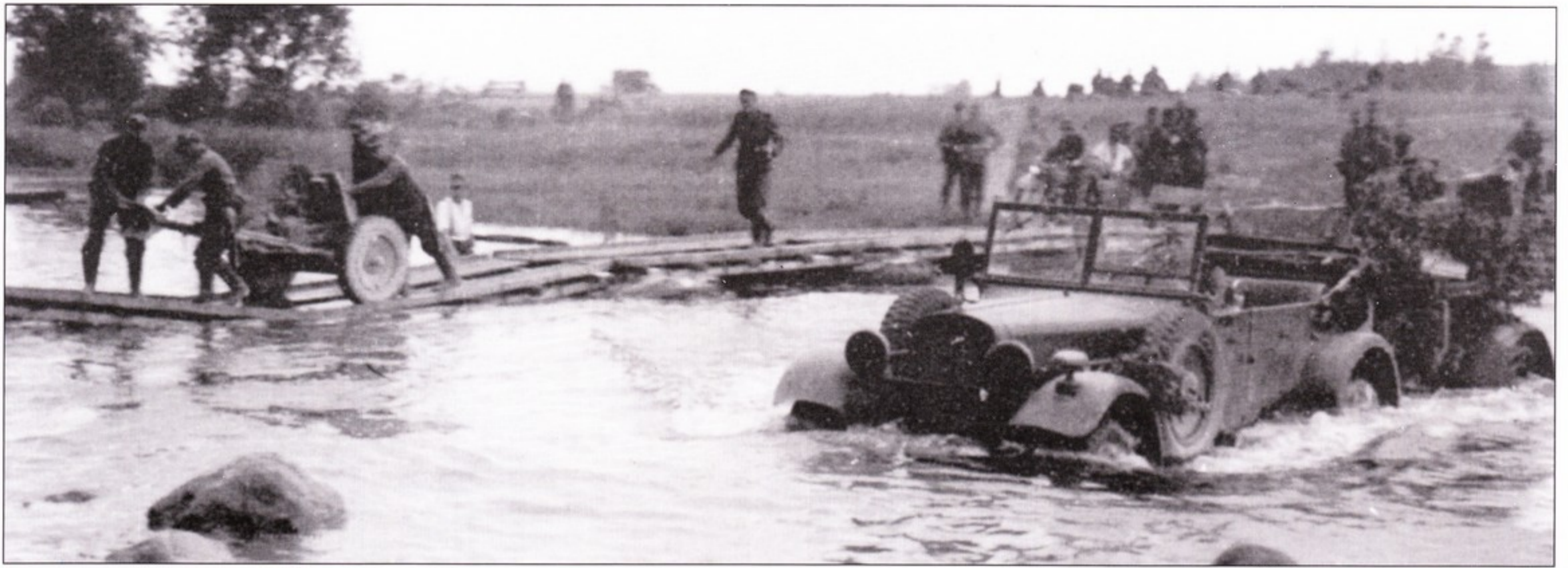
Переправа через речку в Эстонии. Пушку расчет перекатывает по сколоченным на живую нитку мосткам, а автомобиль Вандерер W11 форсирует водную преграду вброд, машина могла самостоятельно преодолевать водные преграды глубиной до 55 см.
