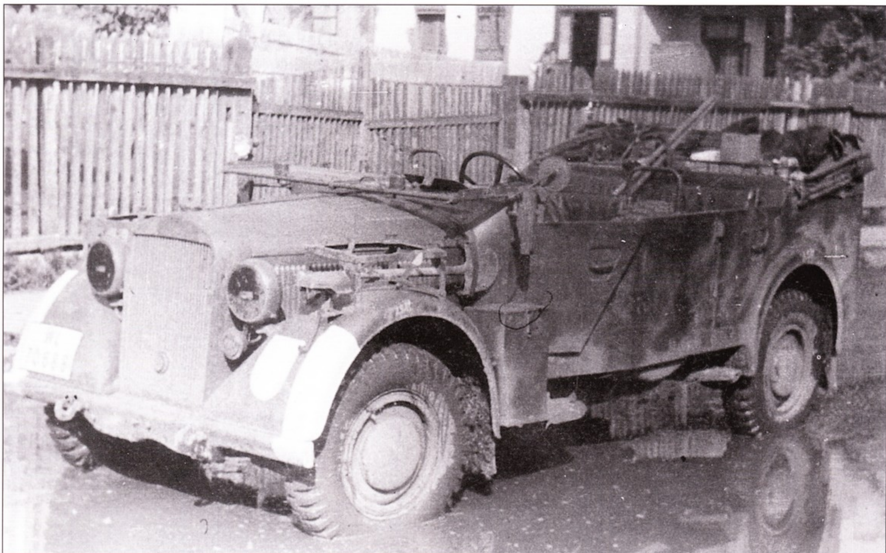
Тип 40. Где? В России, конечно! Лето 1942 г. Начиная с шасси 40 001 в конструкцию автомобиля были внесены серьезные изменения. От средней оси и навешенных на ней колес отказались, а штатным двигателем стал мотор Хорьх V-8 мощностью 80 л.с.
