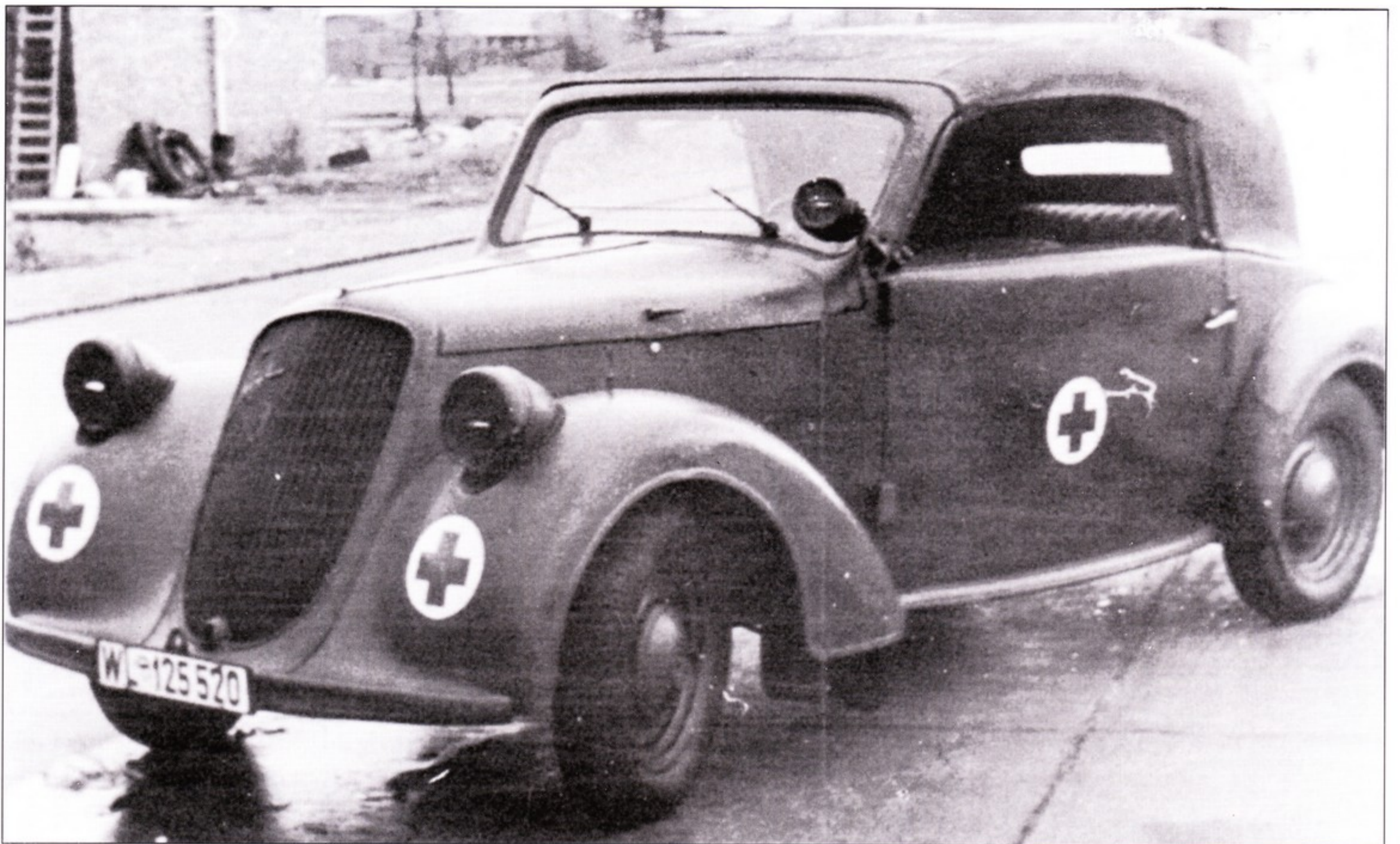
Штейр тип 200 подразделения люфтваффе. На машине стоит 4-цилиндровый двигатель мощностью 35 л.с.; автомобили серийно выпускались в 1936 - 1940 г.г.
