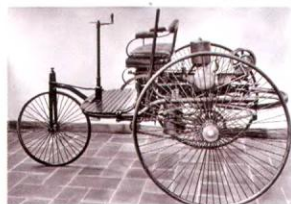
▲ Первый в мире трехколесный автомобиль, изобретенный Карлом Бенцем в 1886 году. Максимальная скорость автомобиля составляла 24 км/ч.
