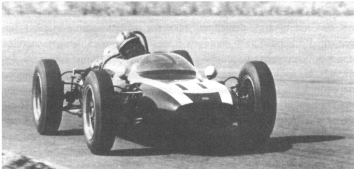
Рис. 51. Джек Бребхем и на этот раз демонстрирует великолепный образец прохождения поворота. Его Купер-Климакс удерживается в классическом силовом скольжении, при этом передние колеса установлены строго прямо. Однако автомобиль движется по дуге поворота благодаря тому, что в результате четко дозированной подачи газа задние колеса скользят чуть сильнее передних. Это – наискорейший способ прохождения поворота. (Гран-при Бельгии, 1960 г., Спа)
