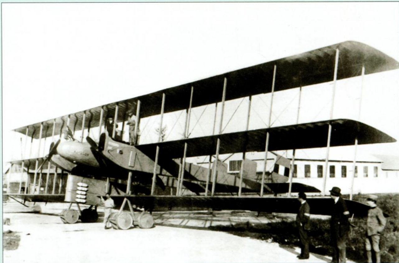
«Капрони» Са.4 стал единственным в мире серийно строившимся многомоторным трипланом
