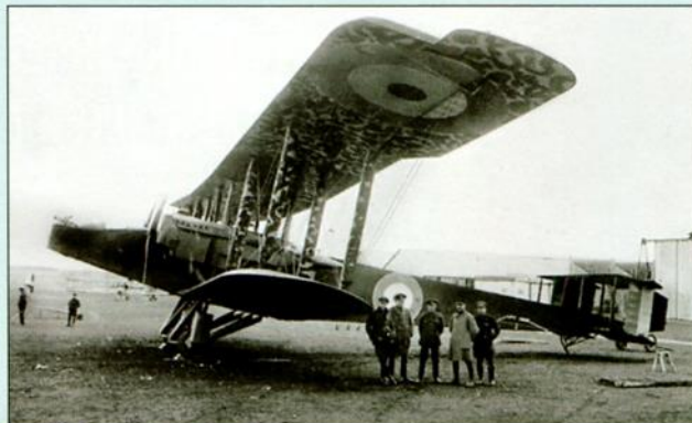
«Хэндли-Пейдж» О/100 являлся полумонопланом с бипланым хвостовым оперением
