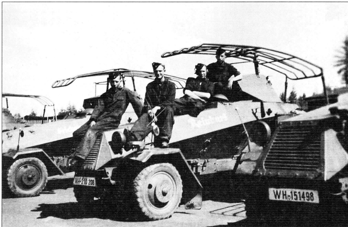
Бронеавтомобили Bussing-NAG (6-Rad) — радиофицированные, имеющие радиостанции FuG Spr Ger «А», о чем свидетельствуют рамочные антенны над корпусом
