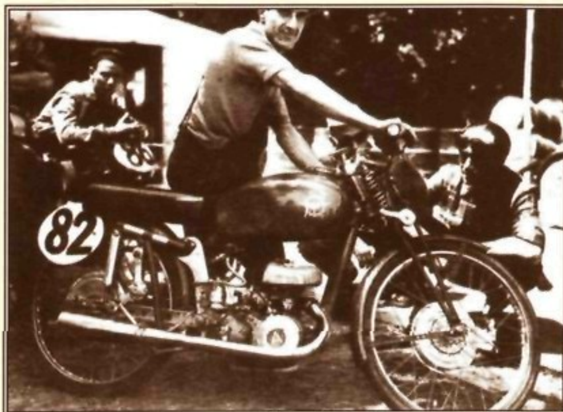
Первая гоночная "МВ Агуста" с двухтактным двигателем.
