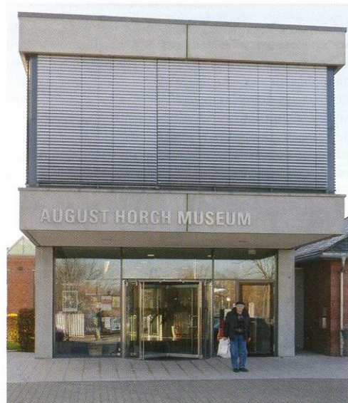
Главный вход – единственная современная постройка в музее Августа Хорхя. Всё остальное находится в зданиях начала XX века.
