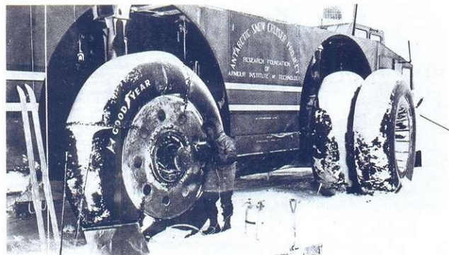
Установка специальных цепей противоскольжения и двоярных передних колёс была предпринята в тщетной попытке улучшить проходимость «монстра».
