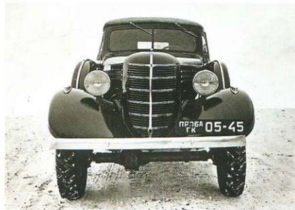
В отличие от первых образцов ГАЗ-61-40, предсерийная машина имела оперение капота и бампера, выполненное по типу ГАЗ-11.
