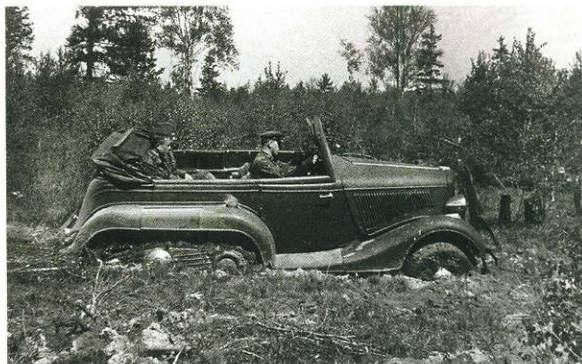
Полугусеничный НАТИ ВМ в рамках войсковых испытаний движется по сильно заболоченной местности. Как видите, в подобных условиях отсутствие привода на переднюю ось ощущалось особенно остро.
