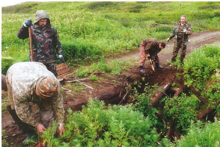
Для перевозки найденных остатков техники к месту погрузки на судно требовались мосты... Но их состояние периодически заставляло нас заниматься восстановительными работами.
