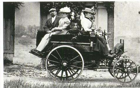
«Dos-à-dos» и «vis-à-vis» – кузова, прямоком доставшиеся первым «самобеглым коляскам» от гужевых экипажей. В переводе с французского название первого звучит как «спина к спине», а второго – «лицом к лицу». В Англии первый кузов называли dog-cart, поскольку под сиденьями часто устанавливался специальный ящик для охотничьих собак.
