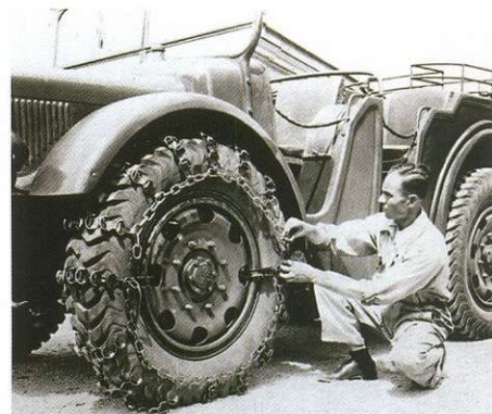
TL 37 с шинами Pirelli Artiglio. Для езды по тяжёлому бездорожью предусматривалась установка вездеходных цепей.
