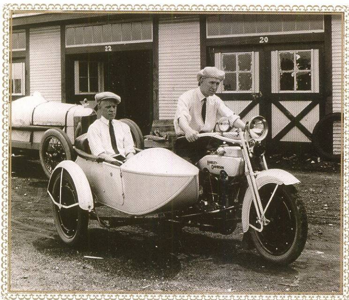
В начале 20-х годов XX века основное оружие Harley-Davidson в борьбе с конкурентами – мотоциклы с моторами типа «клапан под клапаном».
