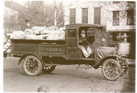
Грузовик Ford TТ (1917–1927 гг.) отличался удлинённой базой, усиленной рамой и червячной главной передачей. Грузоподъёмность – 1 тонна.
