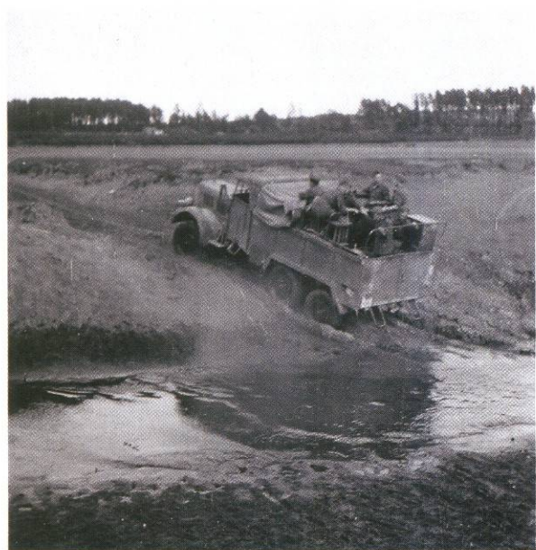
Модификация Kfz. 77 Fernsprechkraftwagen, созданная для связистов, преодолевает брод. Хорошо видны радиостанция и дополнительные укладки, находящиеся в кузове.
