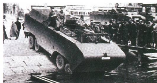
Кузов модификации Kfz.61 Funkkraftwagen, предназначенной для установки радиостанции, был выполнен из дерева.
