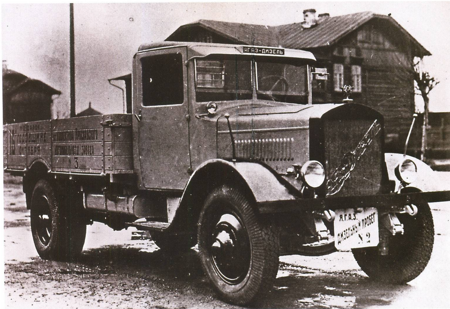
Дизельный Я-5 получил два топливных бака. Один, ёмкостью 135 л, располагался под сиденьем шофера, второй, рассчитанный на 177 л, поместили справа под кузовом. Брилинг отмечал, что «мотор работает на газойле, но может работать и на чистом соляровом масле».
