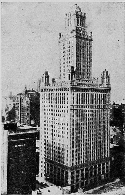
Гараж в 40 этажей в Нью-Йорке. В 23 нижних этажах имеется 550 боксов (помещений для автомобилей), и 17 верхних — деловые помещения. В подвальном этаже — помещения для чистки и ремонта. Автомобили поднимаются наверх специальными подъемниками.
