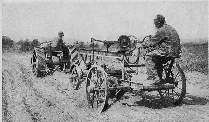
Придание дороге выпуклого профиля посредством „струза“ с тракторной тягой.
