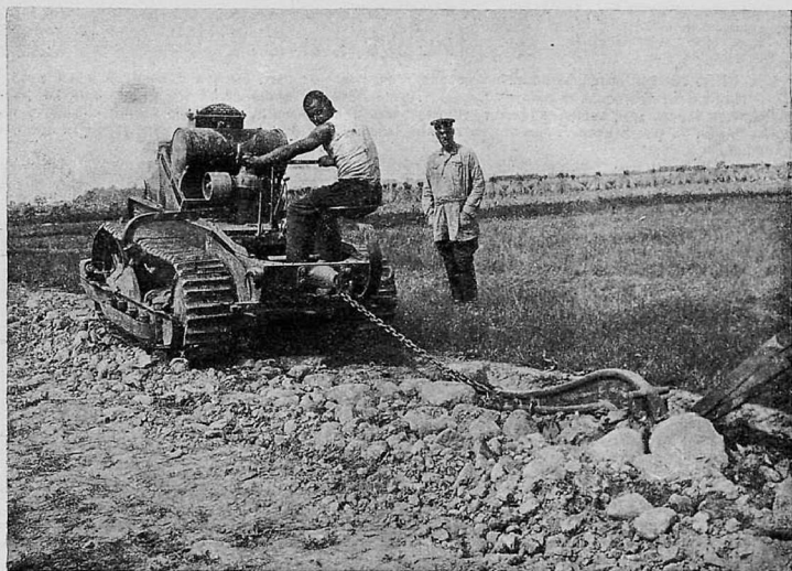
Машина помогает побороть трудные условия постройки дорог. Вспашка каменистого участка дороги дорожным рутером (особым плугом)
