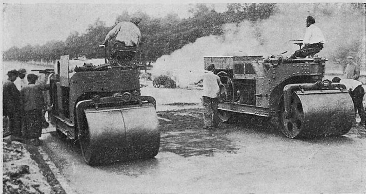
Укатывают асфальто-бетонный участок
