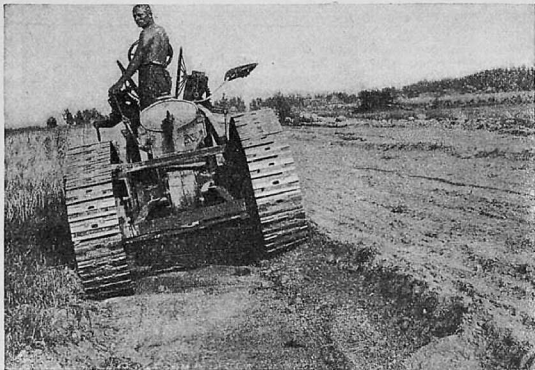
Автоструги на дорожных работах
