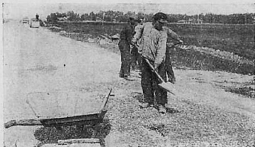
Засыпка „шплинтом“ (каменная мелочь) после поливки шоссе связующим веществом
