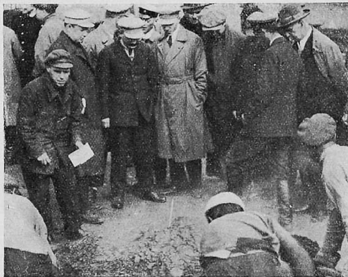
А. М. Лежава (крайний справа) осматривает дорожные работы
