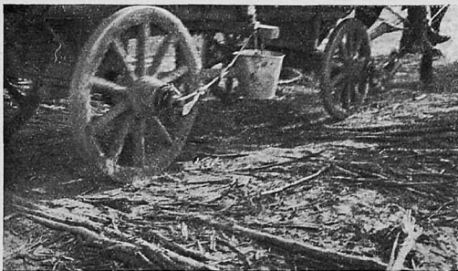
Бытовой способ улучшения непроезжих мест дороги. Улучшение плохого участка грунтовой дороги посредством настила фашин и хвороста
