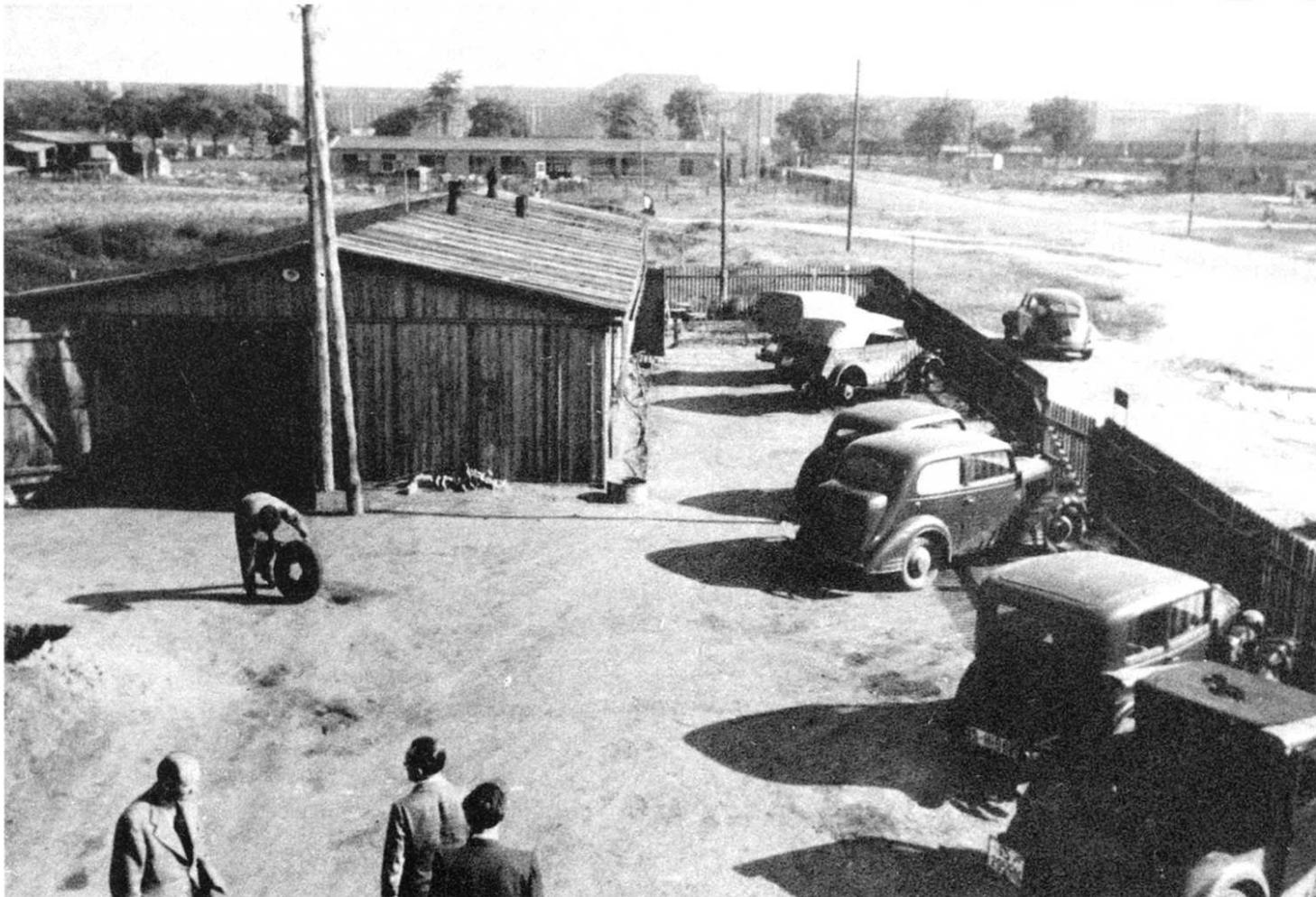
*Ein Werkstattplatz mit den für die Reparatur abgestellten Fahrzeugen. Ein Kübelwagen ist aufgebockt, die Räder sind abmontiert. Dahinter steht ein VW-Käfer mit Kastenaufbau.*
