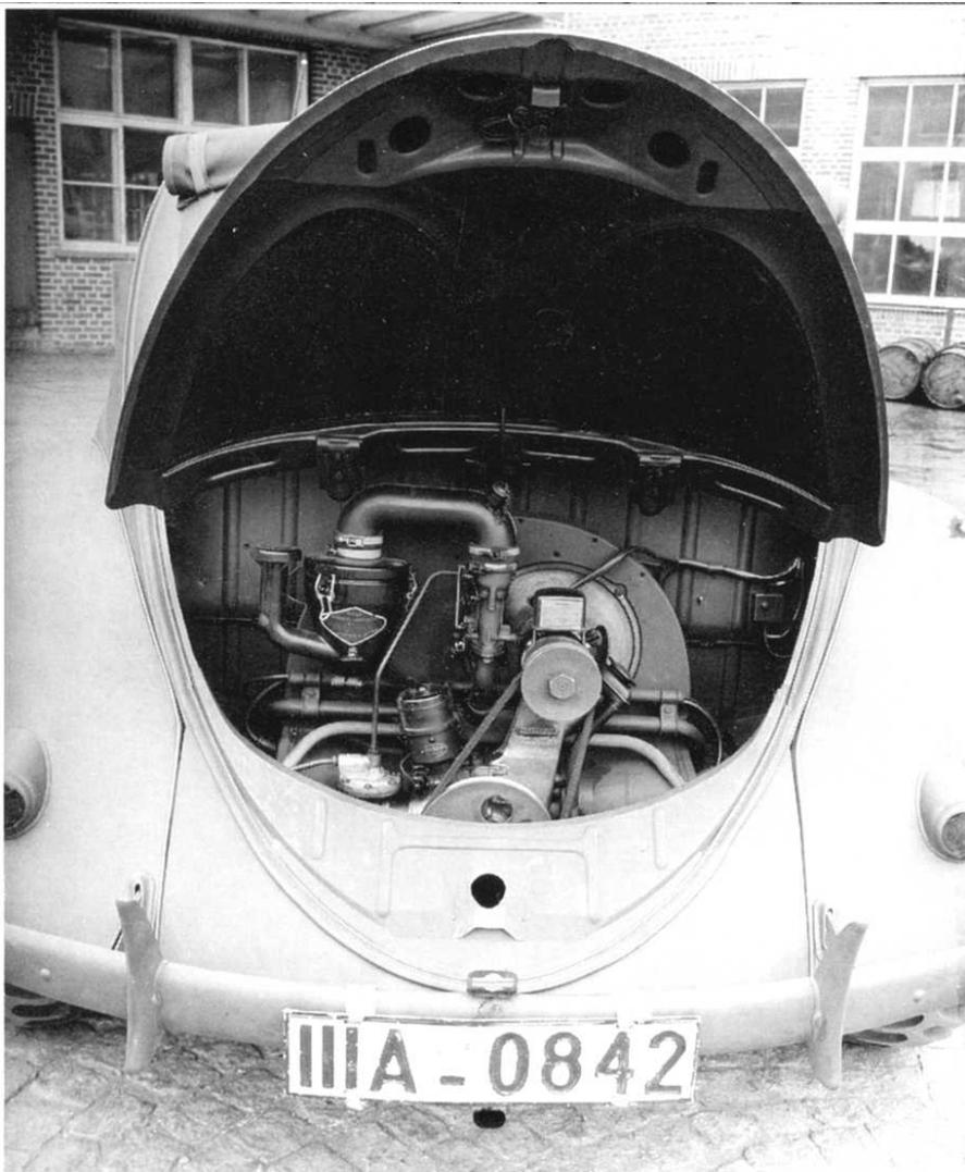
*Motorraum. Deutlich sichtbar der Gebläsekasten und der seitlich versetzte Luftfilter. Das Fahrzeug hat Stuttgarter Kennzeichen.*
