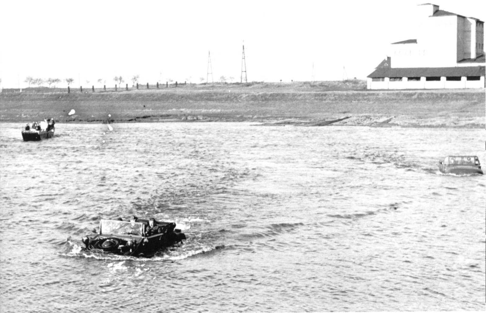
*Schwimmwagen-Prototyp bei Wasserfahrt*
