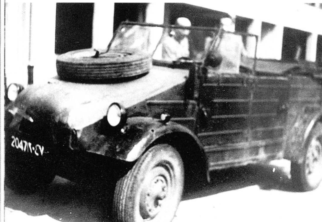
*Bei diesem Kübelwagen wurde die Wagenfront durch eine Haube erhöht. Das Reserverad kam obendrauf.*
