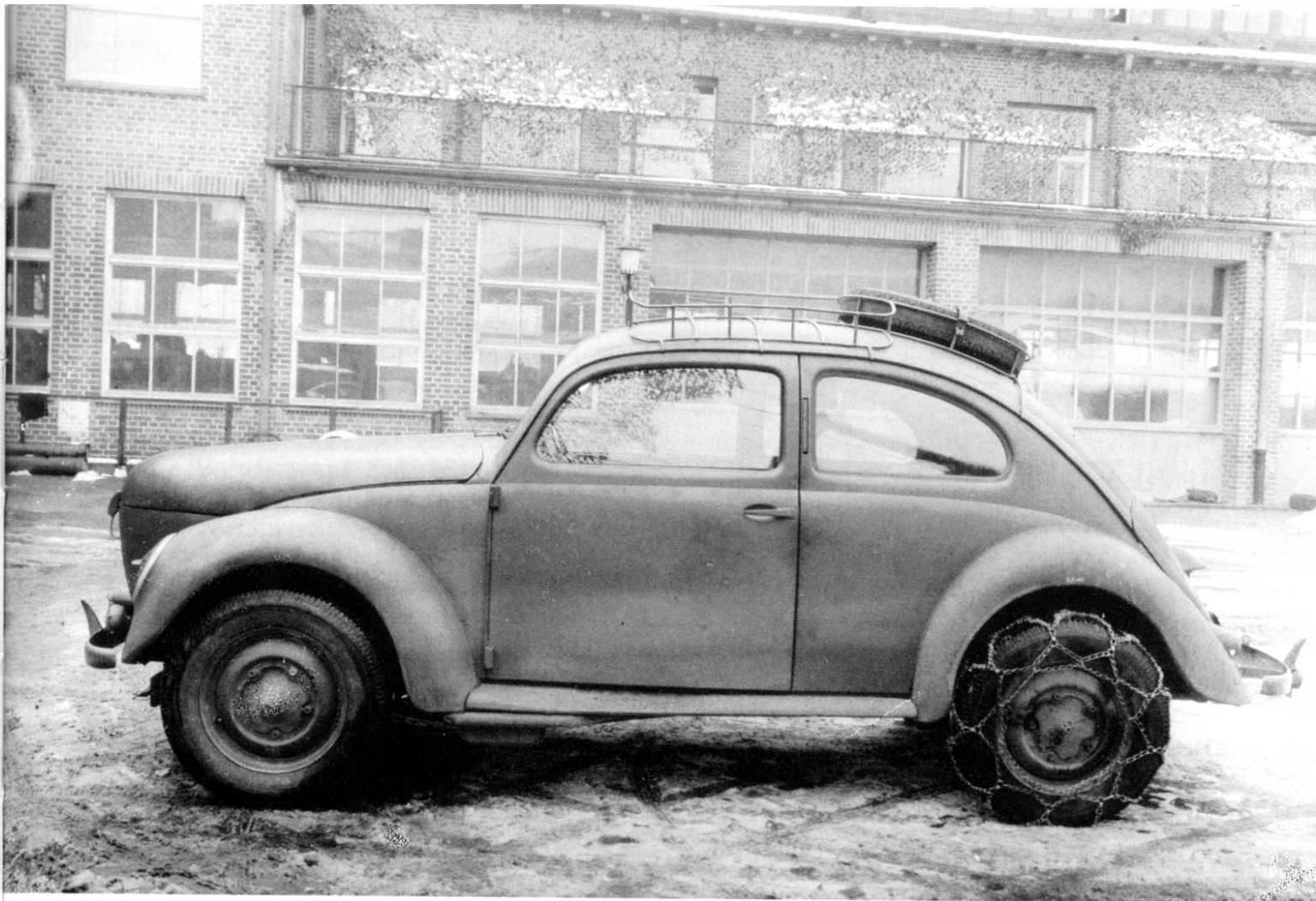
Bei diesem Porsche Typ 230 wurde die Holzgasanlage durch eine stromlinienförmige Verkleidung abgedeckt. Auch für dieses Fahrzeug wurde ein Dachgepäckträger mit spezieller Reserveradhalterung konstruiert. Auf dem Dach wurde bei Pkws der »Festkraftstoff« in Säcken transportiert. Das Fabrikgebäude im Hintergrund ist mit Tarnnetzen bespannt. Bild unten: die geöffnete Haube der verlängerten Frontpartie gibt einen Blick frei auf den Generator und den Vorreiniger.
