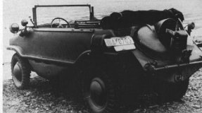
Oben: Ein Vorserienmuster des Schwimmwagens Typ 128, erkennbar an der anderen Motorabdeckung, die auch die Schiffsschraube einschließt und der besonderen Ansaug- und Auspuff-Anlage. Die Achse, um die die Schraube nach unten geklappt wurde, ist hier im Gegensatz zu den späteren Modellen über die ganze Fahrzeugbreite gezogen. Darunter die Klauenkupplung der Zwischenwelle zum Motor, in die die Schraubenwelle einrastete.
