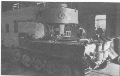
Монтаж башни на танк
