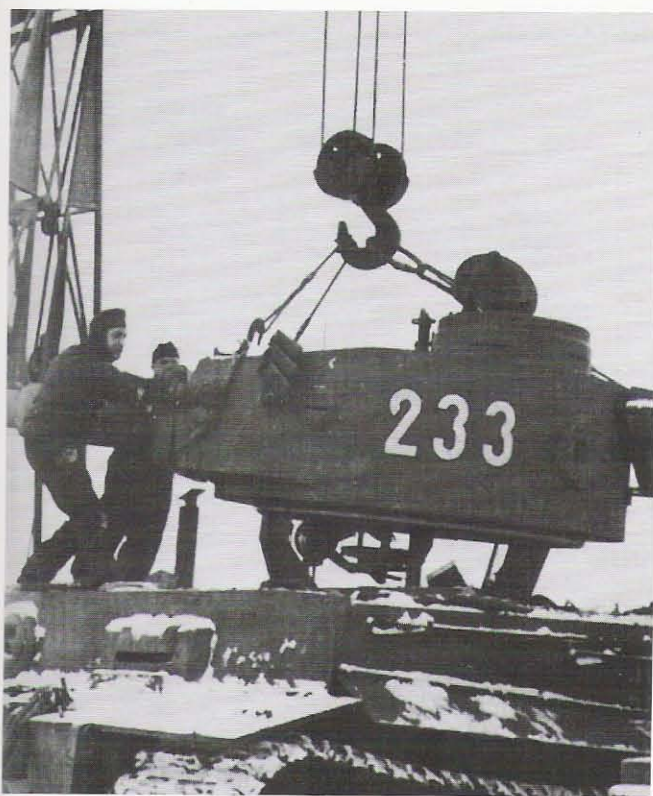
Naprawa „Tygrysa” nr „233” z 2. kompanii 503. Batalionu Czołgów Ciężkich, styczeń 1943 roku. Czołg posiadał zasobnik z PzKpfw III . This “Tiger” coded “233” of 2nd Company 503rd schwere Heeres Panzer Abteilung is being overhauled, January 1943. Tank was fitted with PzKpfw III stowage bin. [CAW]
