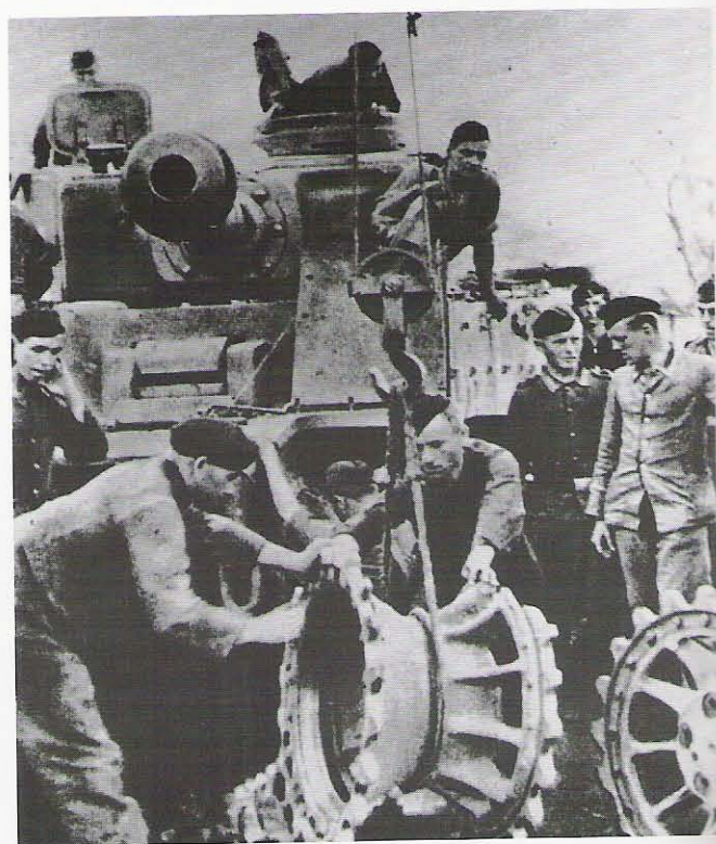
Wymiana kół napędowych w czołgu PzKpfw VI Sd Kfz 181 Ausf. H1 „Tiger” z 503. Batalionu Czołgów Ciężkich wiosną 1943 roku. The changing of drive sprockets in PzKpfw VI Sd Kfz 181 Ausf. H1 “Tiger” tank of the 503rd schwere Heeres Panzer Abteilung, Spring 1943. [Tank Museum 2907/A5]
