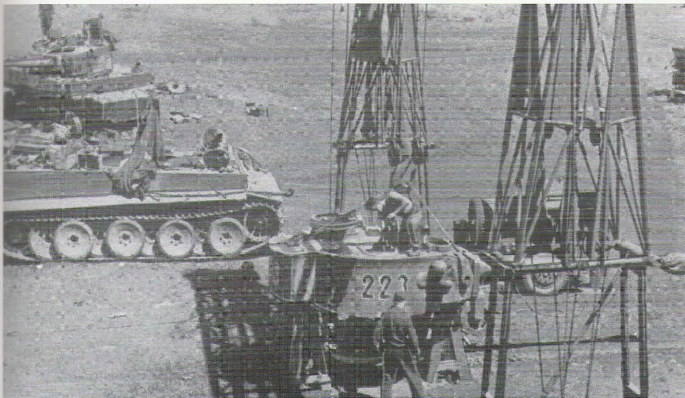
Naprawy czołgów „Tiger” z 503. Batalionu Czołgów Ciężkich, unoszenie wieży czołgu nr „223” i naprawa wentylatorów, front wschodni, 30 lipca i 10 sierpnia 1943 roku. The maintenance of “Tiger” tanks of the 503rd schwere Heeres Panzer Abteilung, Eastern Front, July 30 and August 10, 1943. The turret of No “223” tank is lifted by the crane and replacing of ventilators. [CAW]
