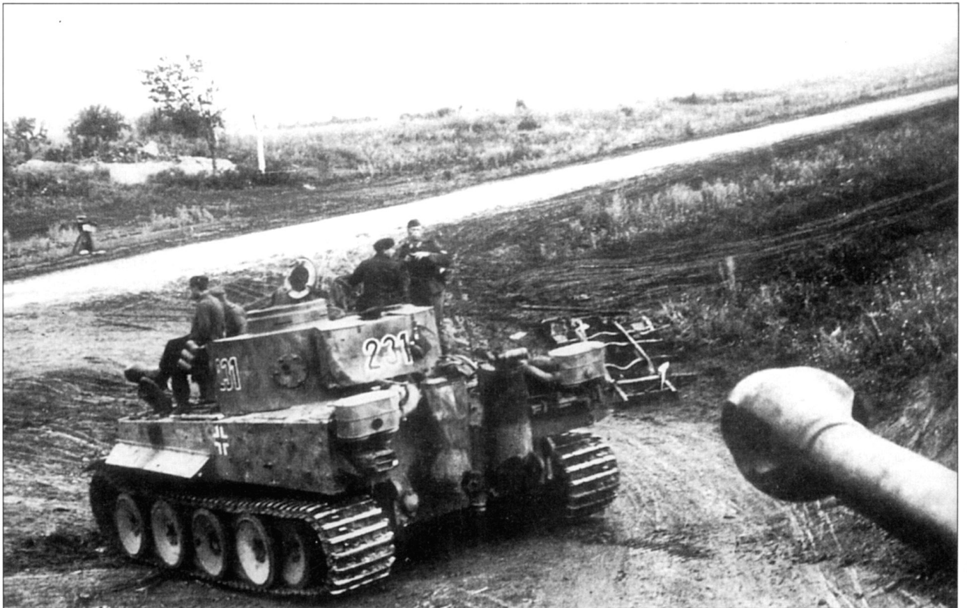
«Тигр» раннего выпуска из 3-го взвода 2-й роты 503-го тяжелого танкового батальона, 1 августа 1943 г. Машина имеет хорошо заметные эксплуатационные повреждения: сильные помятости кожухов выхлопных труб, контейнера на корме башни, утеряны подкрылки и часть секций крыла.
