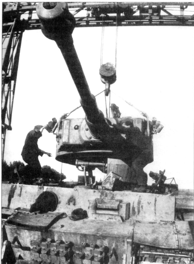
Установка башни на «Тигр» в плевых ремонтных мастерских с помощью крана Freise грузоподъемностью 15 т. Обратите внимание на установленные «уши» для монтажных работ с башней.
