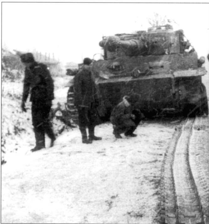
Замена гусеницы «Тигра» требовала недюженых физических усилий. Сначала гусеницы раскладывали на земле, затем загоняли на нее танк, а потом соединяли траки. На снимках - «Тигр» из 2-й роты 505-го тяжелого танкового батальона.
