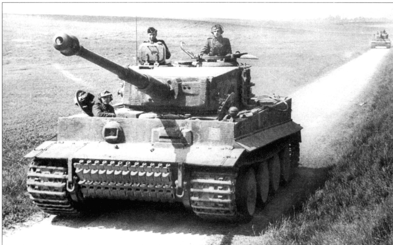
«Тигр» с тактическим номером «323» шарфюрера Баркхаузена. Хорошо видна циммеритная обмазка танка, на нижнем лобовом бронелисте корпуса укреплены запасные гусеничные траки.
