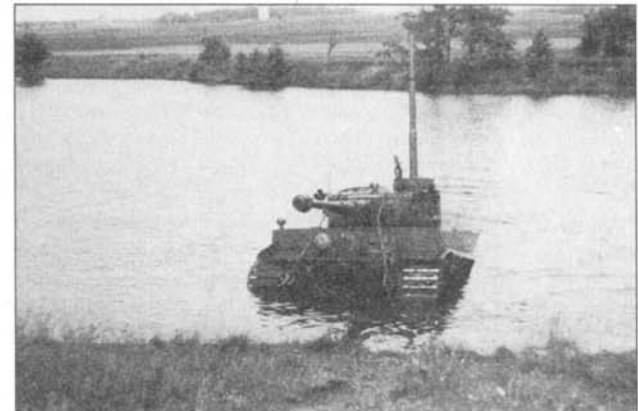
Серия фотографий, сделанная при подводных испытаниях танка «Тигр».
