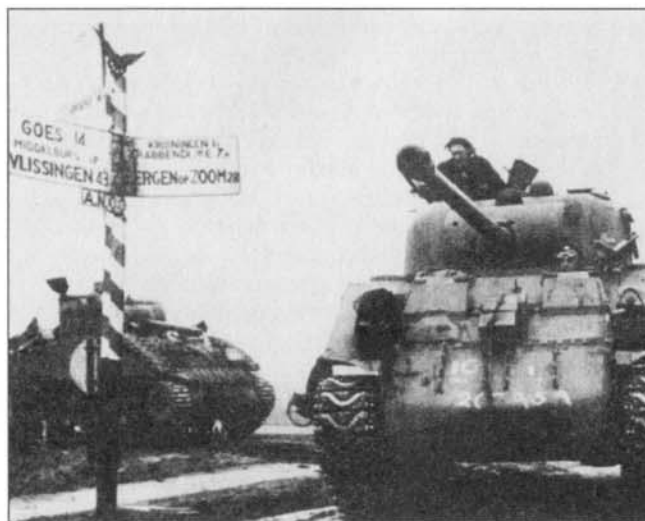
Огневая мощь основного танка союзников - М4 «Шерман» явно не соответствовала реалиям войны, поэтому часть танков было перевооружена английской 17-фунтовой пушкой.
