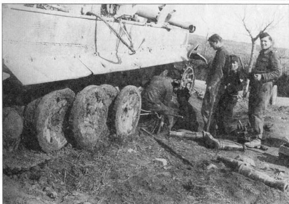
Танкисты ремонтируют подорвавшийся на мине «Тигр». Состоящая из перекрывающихся катков ходовая часть требовала от ремонтников дополнительных усилий для их снятия и установки. Во время таких операций танкисты часто поминали «добрыми» словами конструкторов танка.
