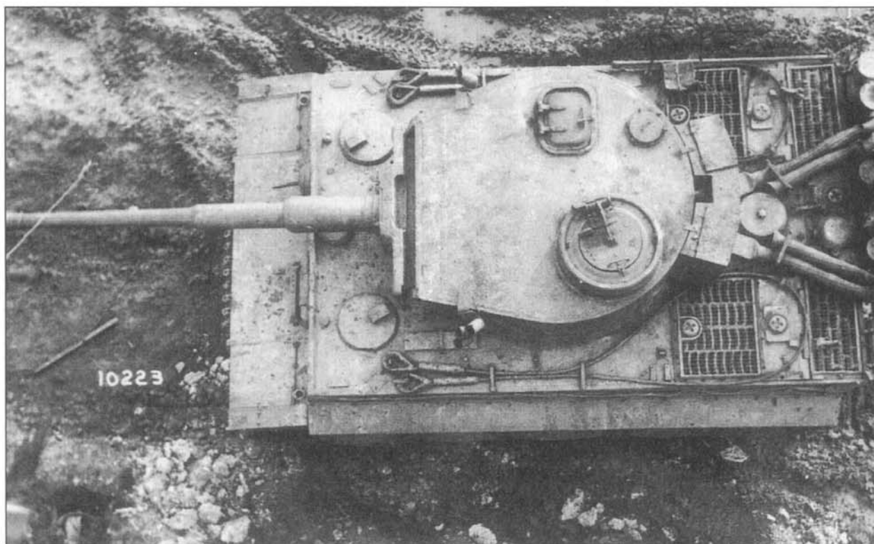
Захваченный англичанами «Тигр» принадлежал первой роте 504-го батальона. Эта часть прибыла в Тунис в марте-апреле 1943 г. На снимке хорошо видно асимметричное расположение пушки в башне. Слева было оставлено больше места для размещения прицела и наводчика. Танк был брошен экипажем после того как у него заклинило башню.
