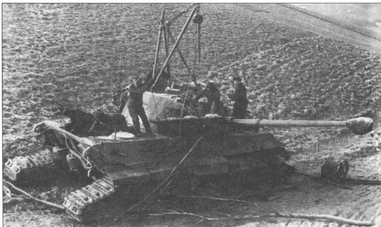
Экипаж «Королевского Тигра» ремонтирует свою машину в полевых условиях
