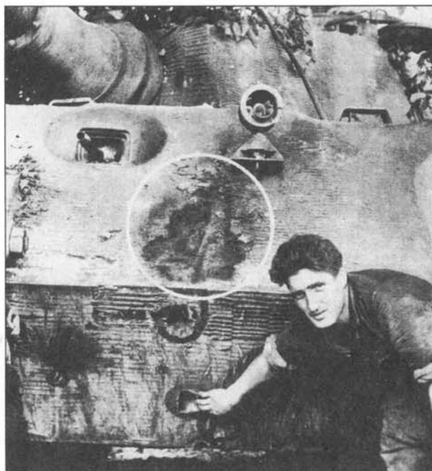
Лобовая броня «Королевского Тигра» не пробивалась противотанковыми средствами союзников
