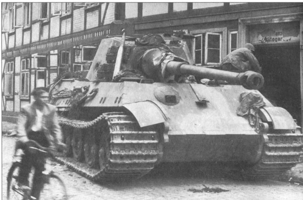
Как и любой другой танк, «Королевский Тигр» был очень уязвим при ведении боевых действий в городе. В правом борту башни этого танка зияет дыра от попадания ракеты выпущенной из «базуки». В обычных условиях это оружие было малоприспособлено для борьбы с немецкими танками.
