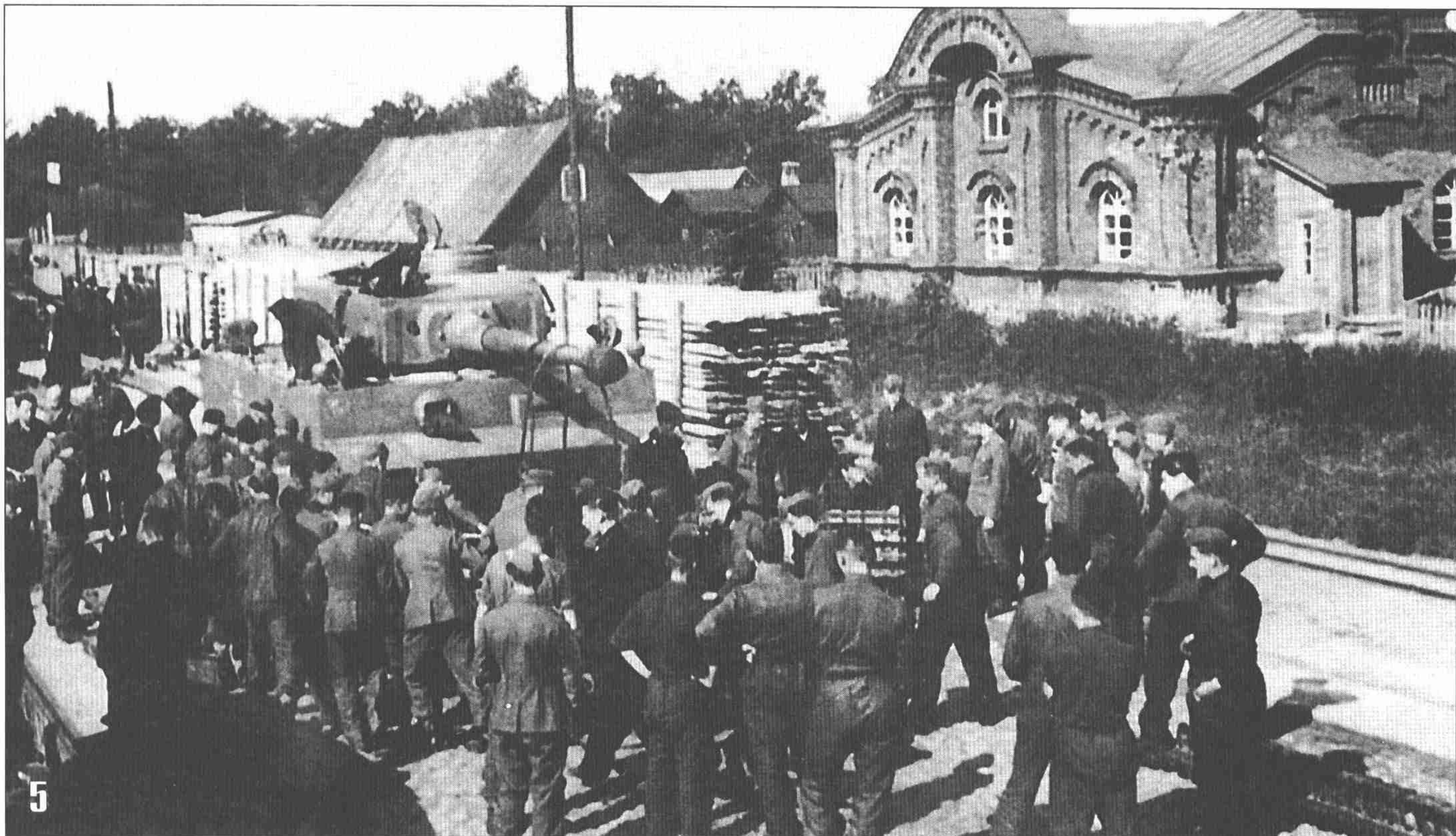
5. Смена гусениц на «Тигре» № 113 перед его погрузкой на железнодорожную платформу для отправки на фронт. Август 1942 года. Слева на лобовом листе просматривается эмблема sPzAbt 502 — белый мамонт с поднятым хоботом.
