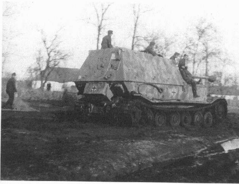
Ein Tiger (P) Elefant oder Ferdinand der schweren Panzerjäger-Abt. 653/654 müht sich durch den ukrainischen Schlamm 1943/44. Diese Fahrzeuge waren wie Sturmgeschütze ohne Drehturm, aber mit sehr leistungsstarker 8,8cm-Langrohrkanone ausgestattet.
