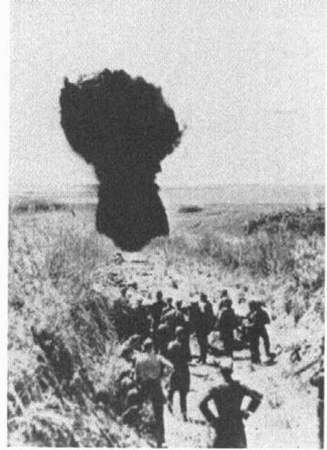
Dann wird ein Panzergraben durch Sprengung eingeebnet.
