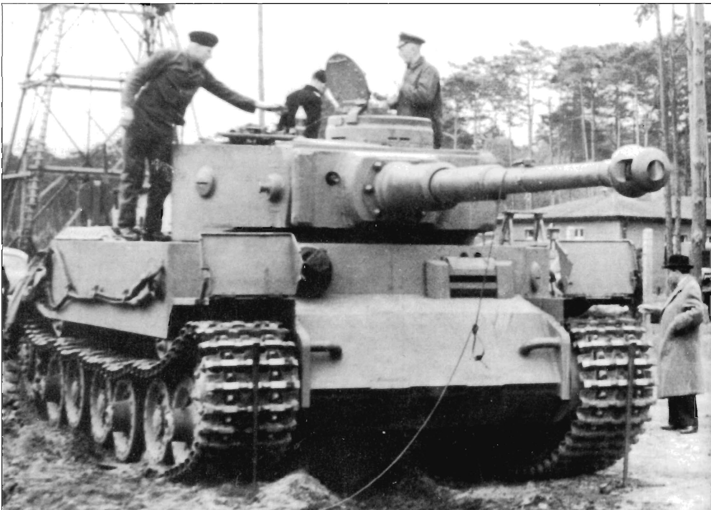
Второй «Тигр» Порше был снабжен башней № 3. Машину осмотрели 3 - 4 июня 1942 г. перед отправкой на полигон Куммерсдорф. Машина получила полный комплект инструмента и оборудования согласно перечню от февраля 1942 г. Шасси одно из пяти первых построенных, с подкрылками шириной 600 мм и гусеницами с траками Kgs. 62/600/130. Крышка люка командира откинута назад в крайнее положение на угол 110 град.
