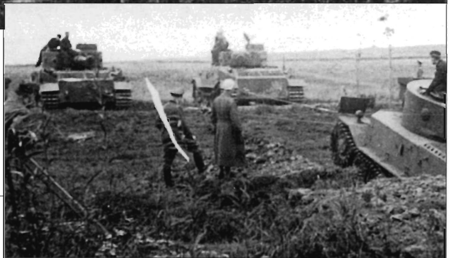
Еще два Truppenübungsfahrzeuge - с башнями № 5 и № 6, 503-й танковый батальон, Дюллерсхейм. Два «Тигра»! пытаются вытащить один «Тигр», который завяз в грязи. Инструмент на этих трех танках размещен по-разному, но все шасси - одной серии с подкрылками шириной 700 мм и гусеницами шириной 600 мм.
