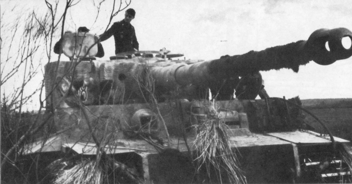
Ein Tiger mit der neueren Kommandantenkuppel – der weggeschwenkte Deckel ist rechts neben dem Ring für das Flieger-MG auf der Kuppel erkennbar. Viele Tiger – wie auch dieser – hatten auch während des Einsatzes die Abschleppseile eingeklinkt. (BA)
