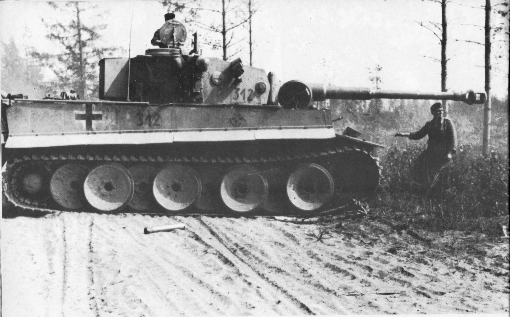
Dieser und der auf der gegenüberliegenden Seite (unten) abgebildete Tiger scheinen nach der Art der Anbringung des Balkenkreuzes und Nummer zum selben Verband zu gehören. Die runden beiderseits des Turmes aufgesetzten Panzerplättchen (hier zwischen Stahlhelm und Wurfbecher) dienten zum Schutz der Sehschlitze für Richtschütze und Ladeschütze.(BA)
