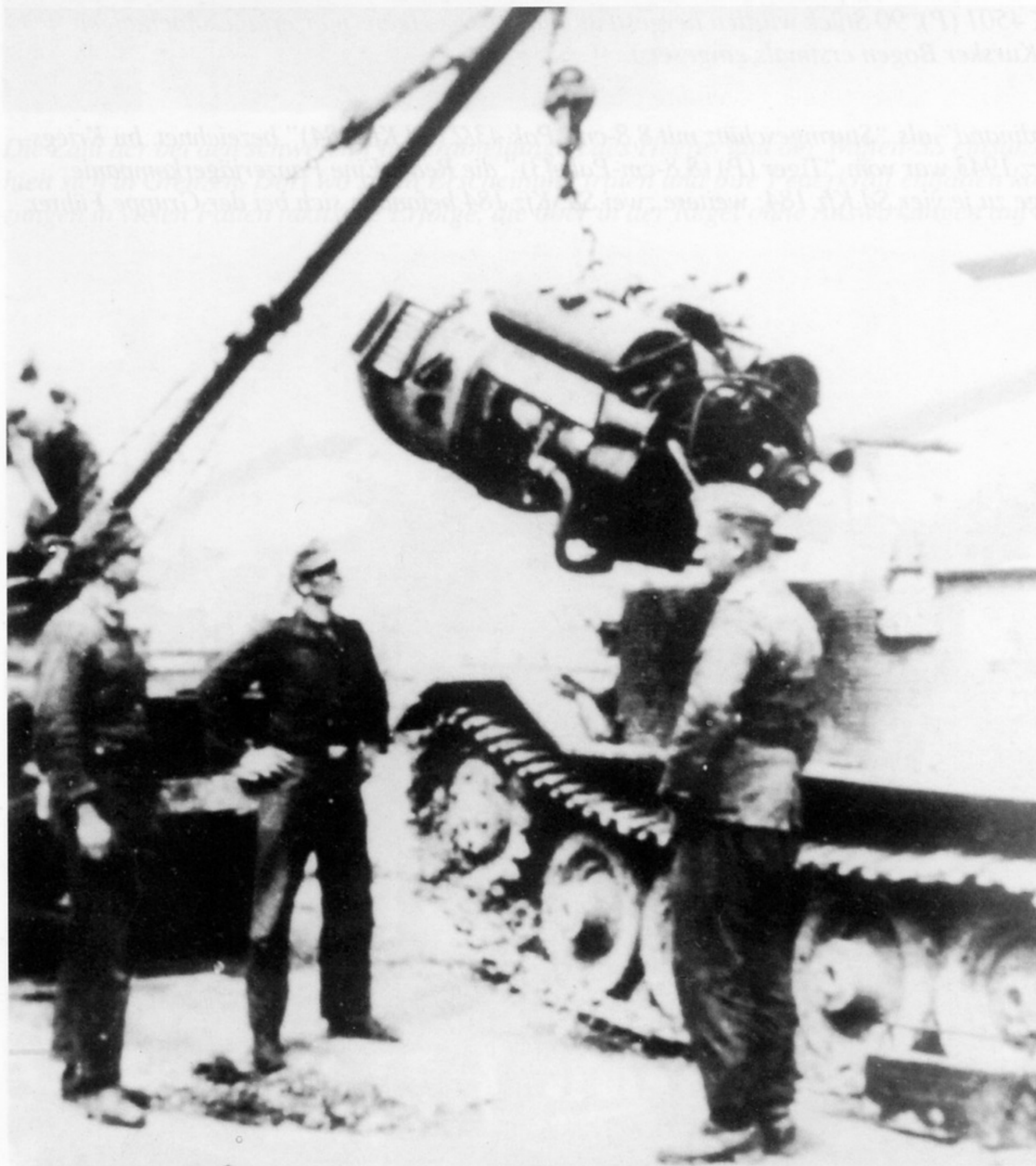
Die schweren Jagdpanzer "Ferdinand" erwiesen sich im Einsatz als sehr störanfällig. Nachteilig machte sich weiterhin der geringe Kampfsatz (55 Granatpatronen) und das Fehlen einer Nahverteidigungswaffe bemerkbar. Letztere wurde später nachgerüstet.
