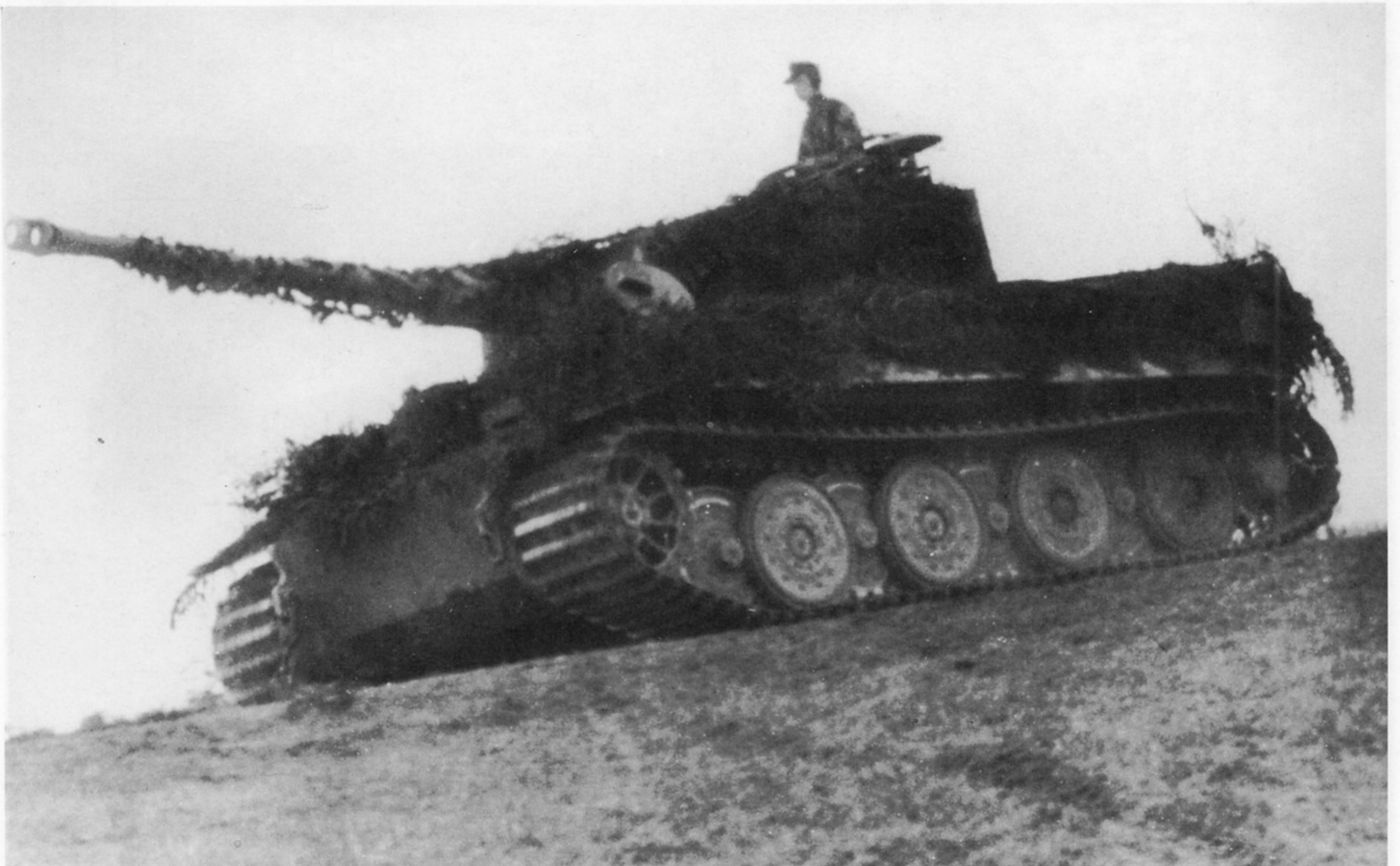
“Tiger”-Panzer der Abschlußausführung mit der Panzerführerkuppel (neuer Bauart) und dem Laufwerk mit gummisierenden Stahllaufrollen. Davon sind ab März 1944 noch einmal über 500 Stück zur Auslieferung gekommen. Die Abbildung unten zeigt ein solches Fahrzeug bei der schweren Panzerabteilung der Panzergranadierdivision “Großdeutschland” nördlich von Mitau. Aufnahme vom September 1944.
