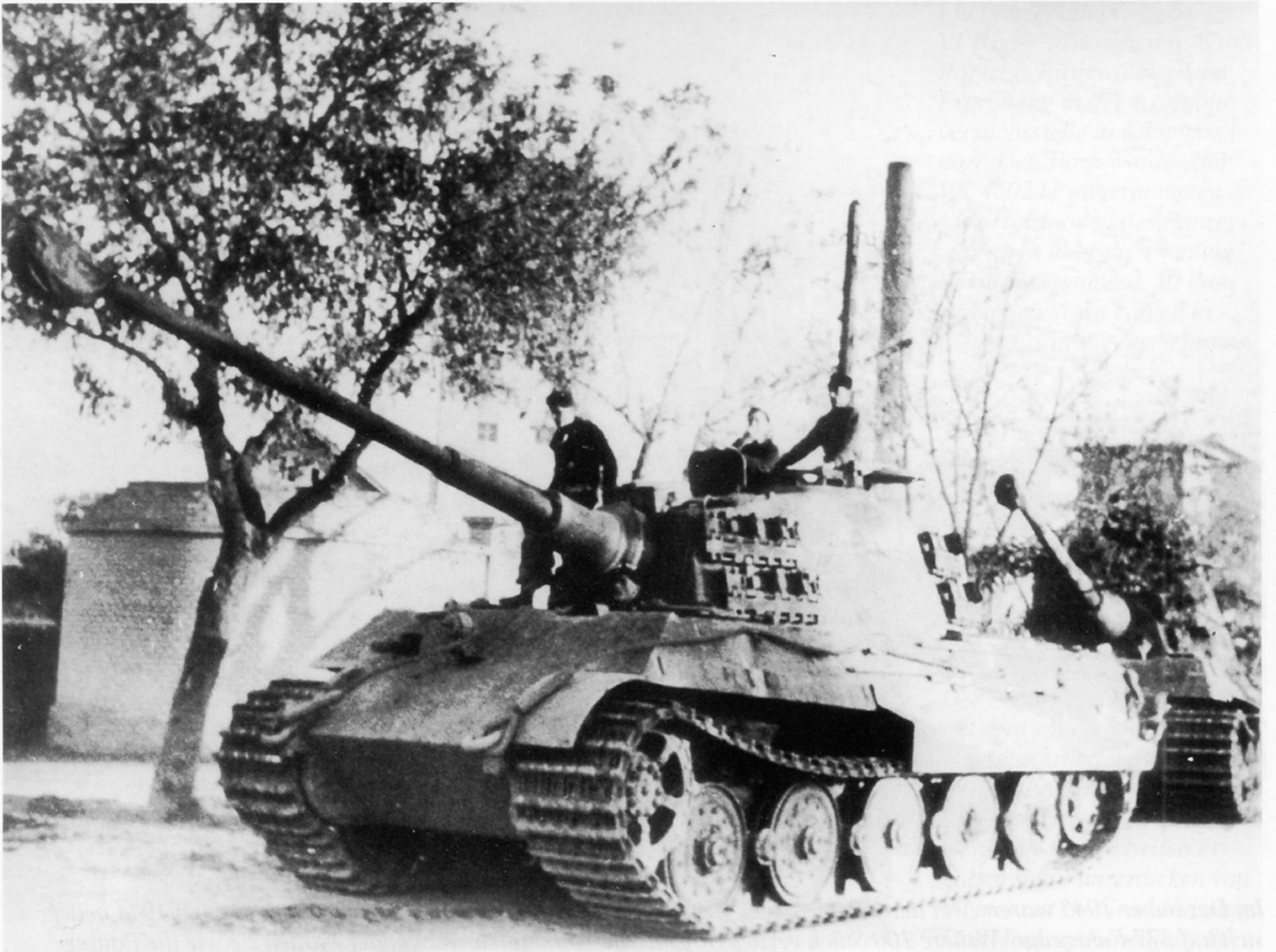
Panzerkampfwagen VI "Königstiger" (Sd.Kfz.182) bei einem Einsatz in Ungarn. Aufnahme vom 15. November 1944. Gut zu erkennen die 0,8 m breite Geländekette. Sie bestand aus 90 Gliedern, von denen 45 Glieder zwei Führungszähne haben, während die anderen 45 nur Verbindungsglieder waren. Das Gewicht schwankte je nach Ausführung zwischen 2,8- und 3,2 t.
