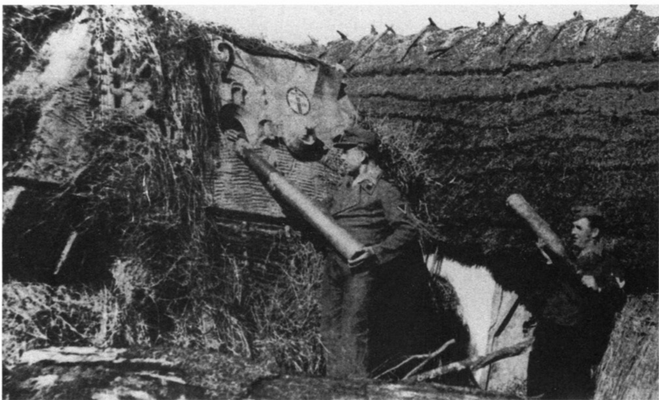
Загрузка боеприпасов в «Элефант» была нелегким делом. Апрель 1944 года, район Тернополя. На фото машина 3-й роты 653-го батальона с бортовым номером 332, хорошо виден лючок для загрузки снарядов и новая эмблема батальона (ЯМ).
