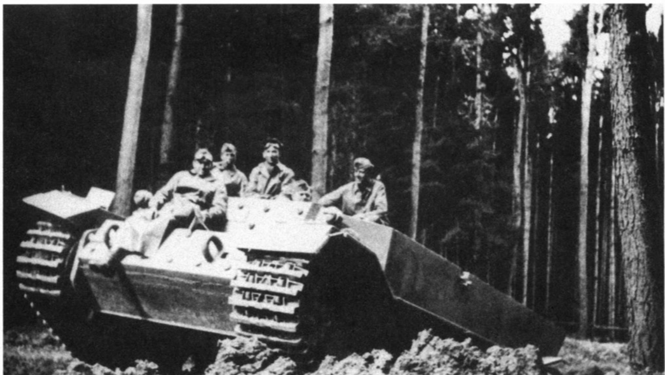
Испытание одного из двух первых шасси «Фердинанда» с демонтированной рубкой. Весна 1943 года. В борту виден заваренный круглый люк (КМ).
