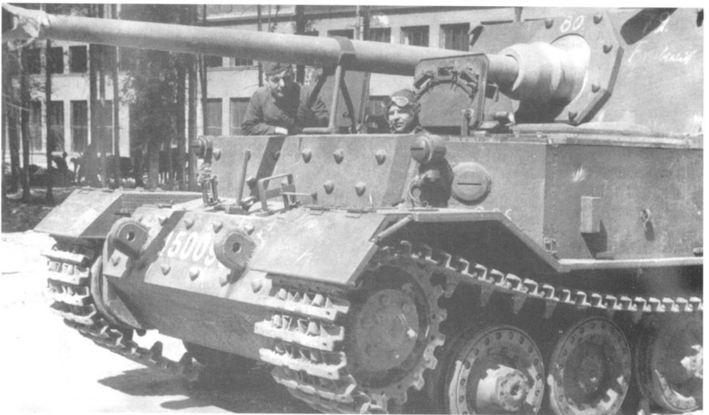
U góry. Jagdpanzer „Tiger“ (P) „Ferdinand“ Fgst 150 091 w czasie montażu Nibelungenwerk w St. Valentin w 1943 roku. Montaż gąsienic i opancerzenia przedziału silnikowego. Powyżej. Działo samobieżne „Ferdinad“ Fgst 150096, pojazd bez dodatkowej osłony jarzma armaty, kwiecień 1943 roku. Top. A final assembly of the tracks and engine compartment armour of the “Tiger”(P) “Ferdinand” Fgst 150 091 SP gun. Above. An early “Ferdinand” Fgst 150096 without additional armored cover of the gun yoke, April 1943. [ASKM]
