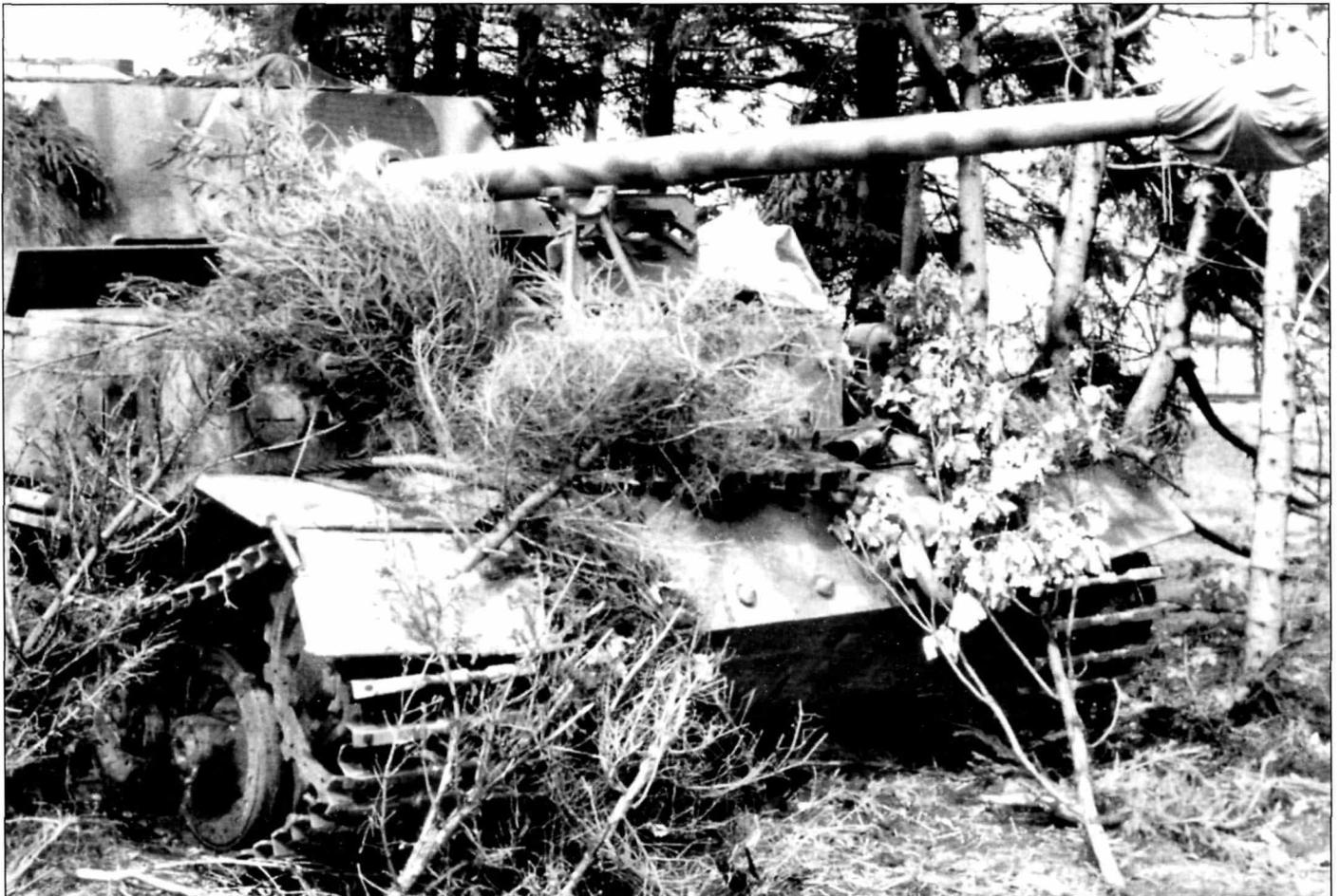
*Замаскированный ветками и срубленными деревьями камуфлированный «Фердинанд» из II/656 (654) в ожидании приказа открыть боевые действия на Курской дуге. Вентиляционные отверстия в крыше корпуса перед рубкой открыты - конец июня, жара! Хотя фиксатор ствола в походном положении поднят, ствол в нем не зафиксирован. Данный факт указывает на то, что снимок сделан не фотокором из ведомства Геббельса, а отражает реальную ситуацию.*
