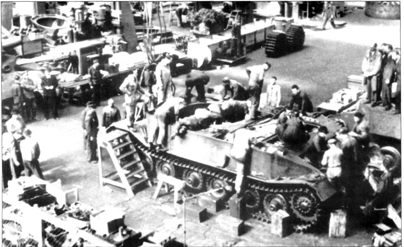
*Монтаж шасси прототипа танка VK4501 «Тигр» в заводском цеху фирмы Нибелунгенверке.*
