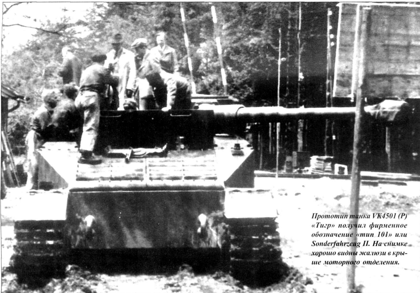
*Прототип танка VK4501 (P) «Тигр» получил фирменное обозначение «тип 101» или Sonderfahrzeug II. На снимке хорошо видны жалюзи в крыше моторного отделения.*
