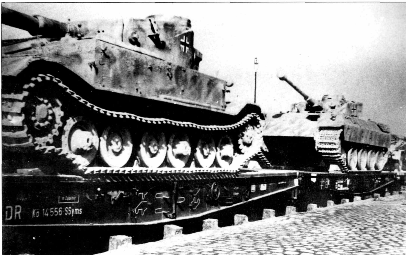
Эшелон с экзотической техникой 653-го батальона, весна 1944 г. На переднем плане виден единственный воевавший «Тигр» Порше. На корпус прототипа VK 4501 (P) установлена башня от ранних «Тигров». За «Тигром» видна ремонтно-эвакуационная «Пантера» с приваренной башней от Pz IV.
