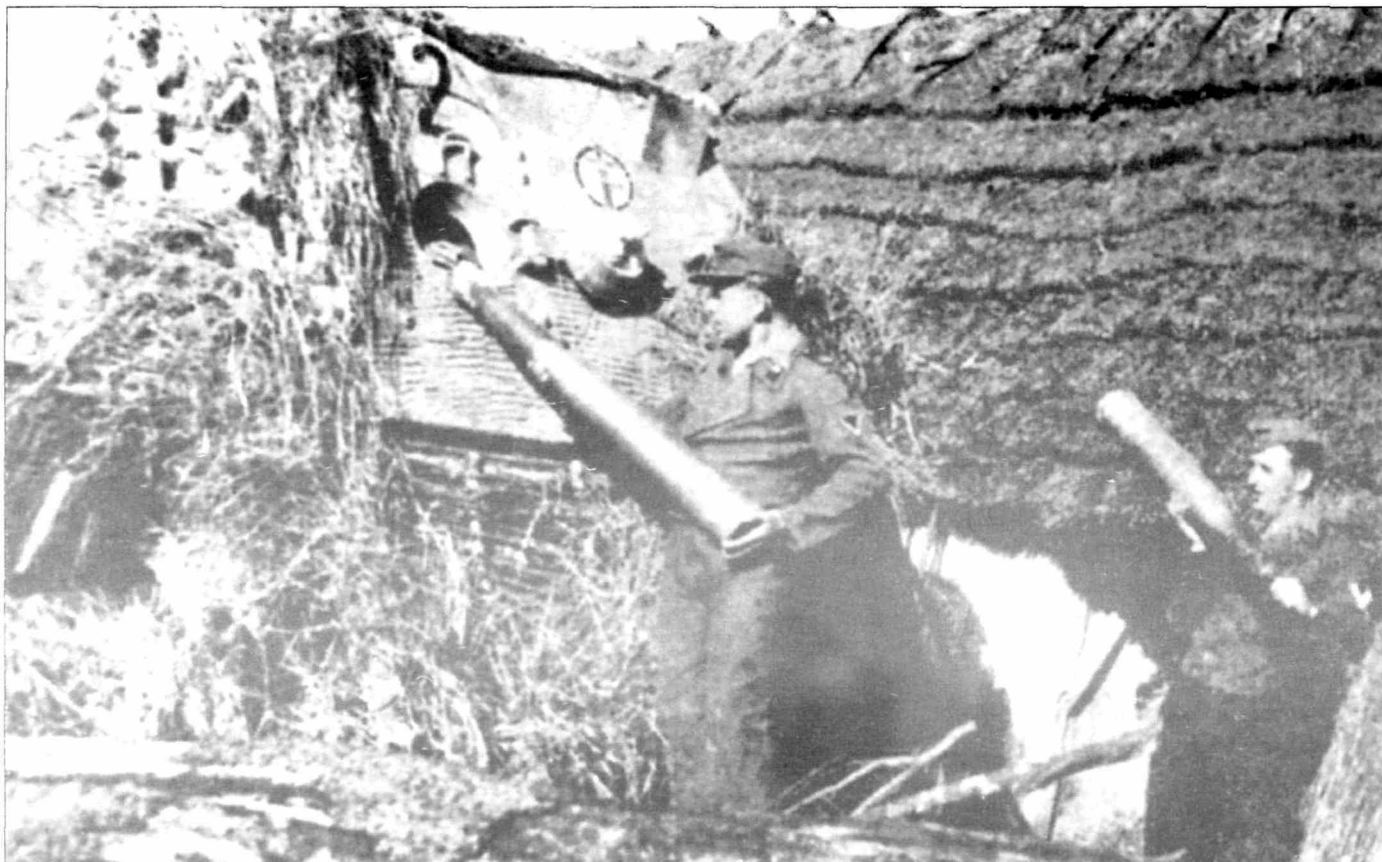
Погрузка боеприпасов выполняется через специальный лючок в крышке заднего люка рубки. Необычно нанесен бортовой номер – по центру кормового бронелиста рубки, над люком. Цифра – полностью черная, скорее всего «Элефант» принадлежит 3-й роте, однако внутри эмблемы батальона нет цифры: машина штаба батальона?
