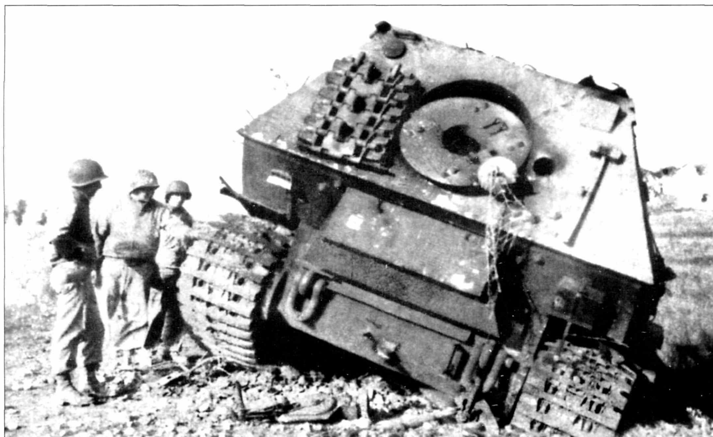
Поврежденный и сожженный «Элефант» фельдфебеля Кюхля осматривают американцы. Рядом с машиной валяется домкрат, посредством которого пытались поднять самоходку перед неудачной попыткой буксировки. К правой серьге подцеплен трос. Пожар внутри боевого отделения, спровоцированный самими немцами, привел к внутреннему взрыву, выбившему кормовой люк и заглушки pistolетных амбразур.
