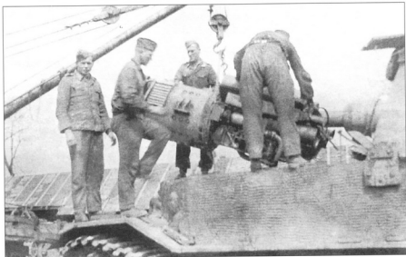
Замена силового агрегата «Элефанта» — ремонтники устанавливают двигатель HL 120 Майбах (Maybach).
