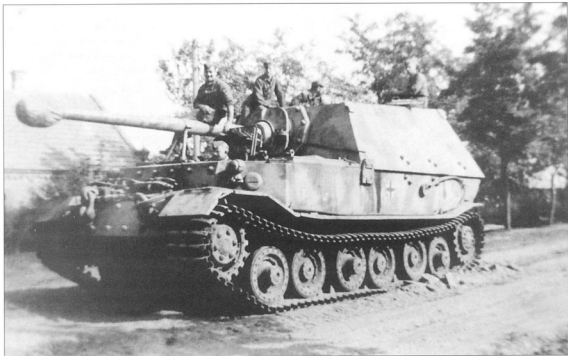
«Фердинанд» на марше. На кормовом листе рубки закреплена канистра с водой (белый крест обозначает, что канистра заполнена водой, а не бензином). На этой машине отсутствует крепление кувалды на левом борту корпуса.
