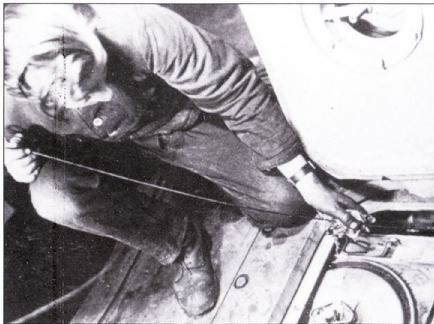
Проверка уровня масла в двигателе
