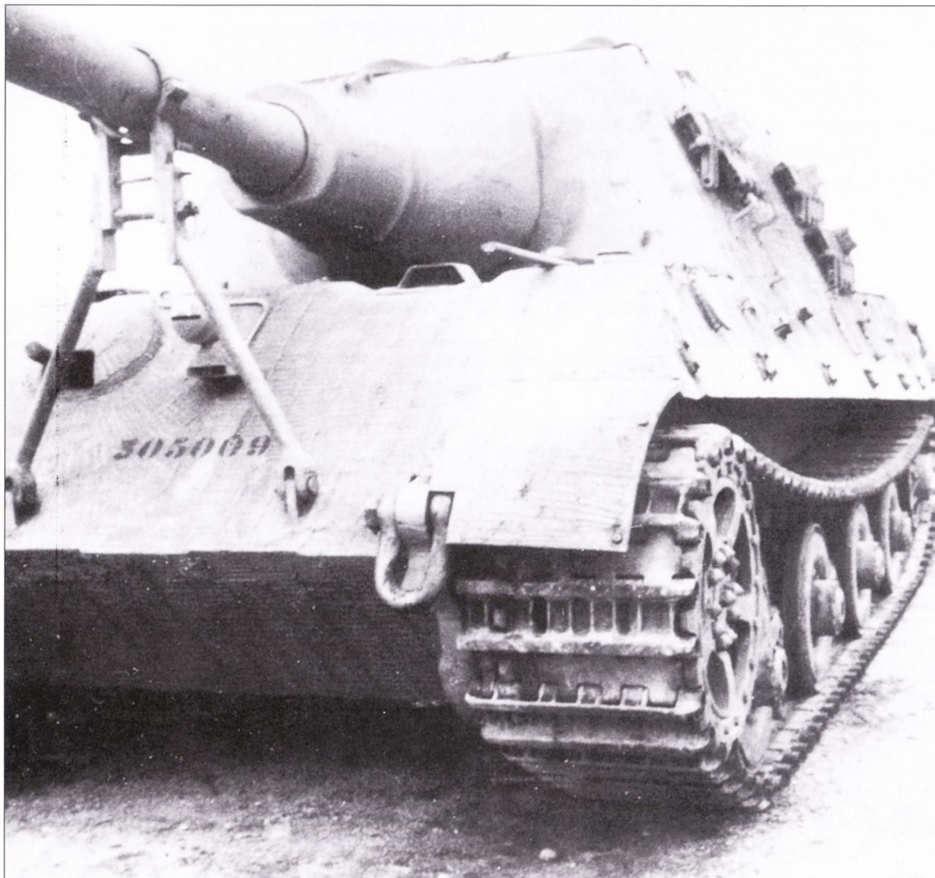
«Ягдтигр» шасси № 305009 с транспортными гусеницами, набранными из траков Gg-24/660/300. Самоходка только сошла с ж.д. платформы.
