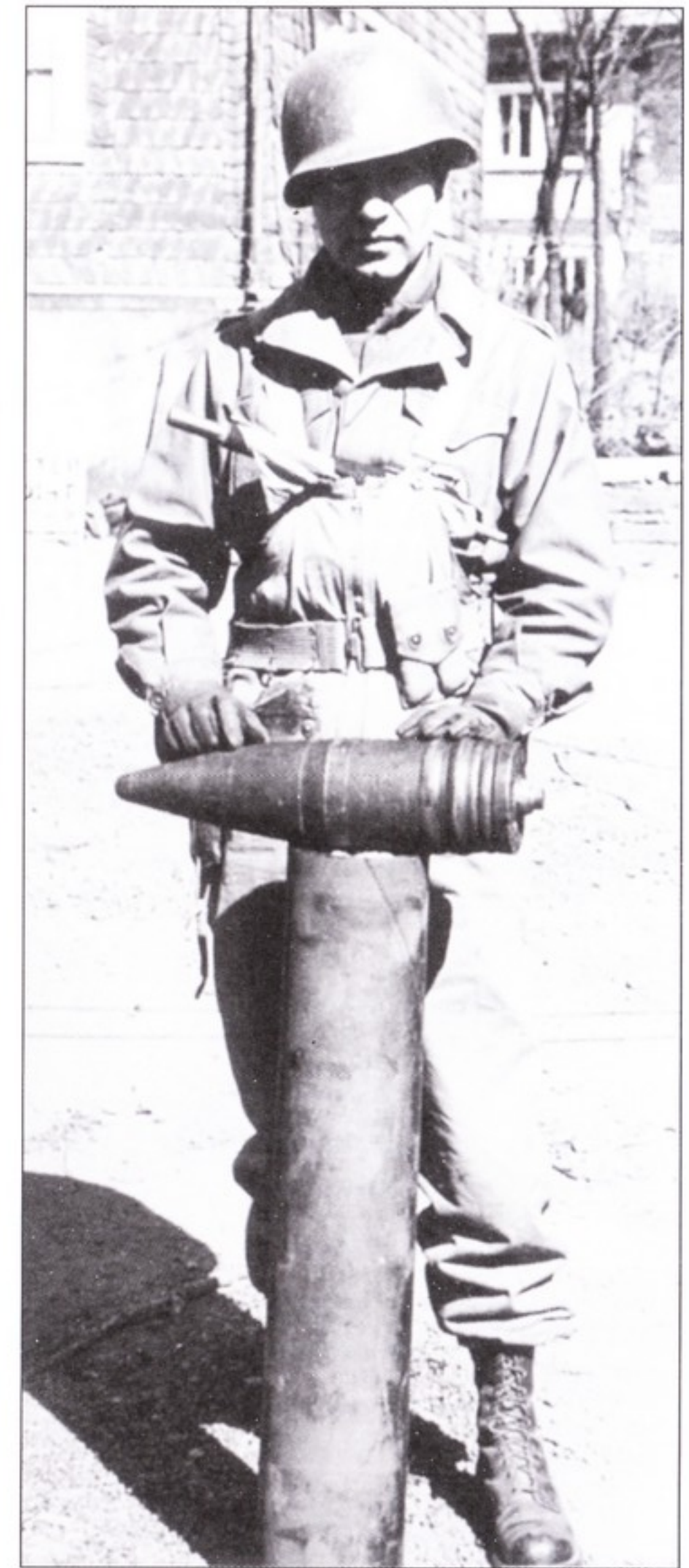
128-мм пушка «Ягдтигра» имела раздельное заряджение.
