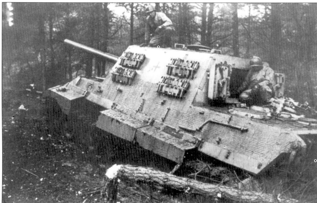
Захваченный союзниками самоходный истребитель танков 12,8 см PaK 44 auf Panzerjaeger «Tiger» SdKfz 186 «Jagdtiger», машина на шасси типа Porsche. «Ягдтигр» принадлежал 512-му батальону. Машина окрашена желтой краской и покрыта цинмеритом. Tактический номер не виден, не заметно и никаких боевых повреждений
