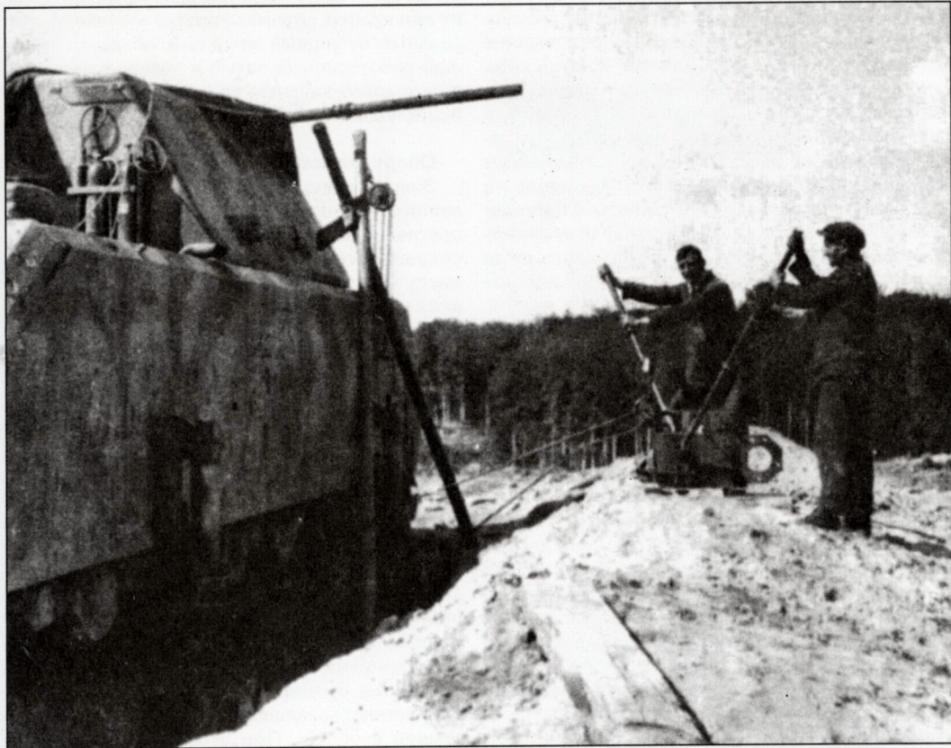
Замена опорной тележки ходовой части танка в полевых условиях.
