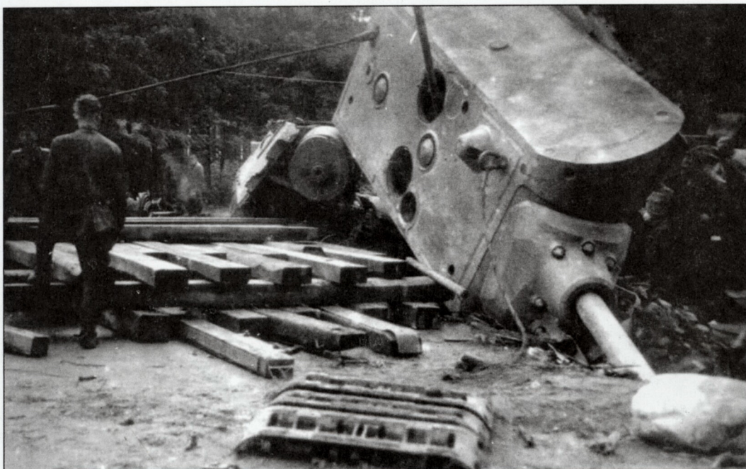
Момент кантовки, башня опрокидывается на клетку из шпал.
