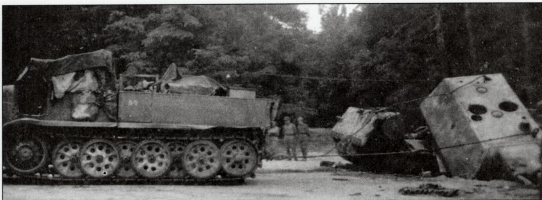
Крепление тросов к башне танка.
