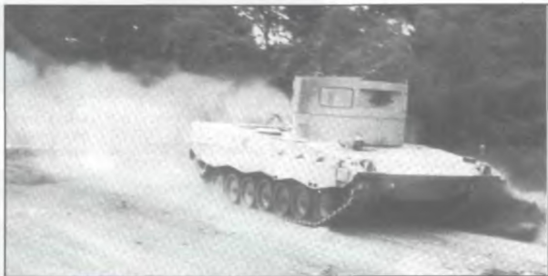
■ Опытный танк «Леопард-2AV» со снятой башней (вместо нее установлена цилиндрическая надстройка) в ходе испытаний на Абердинском полигоне, 1976 г.
