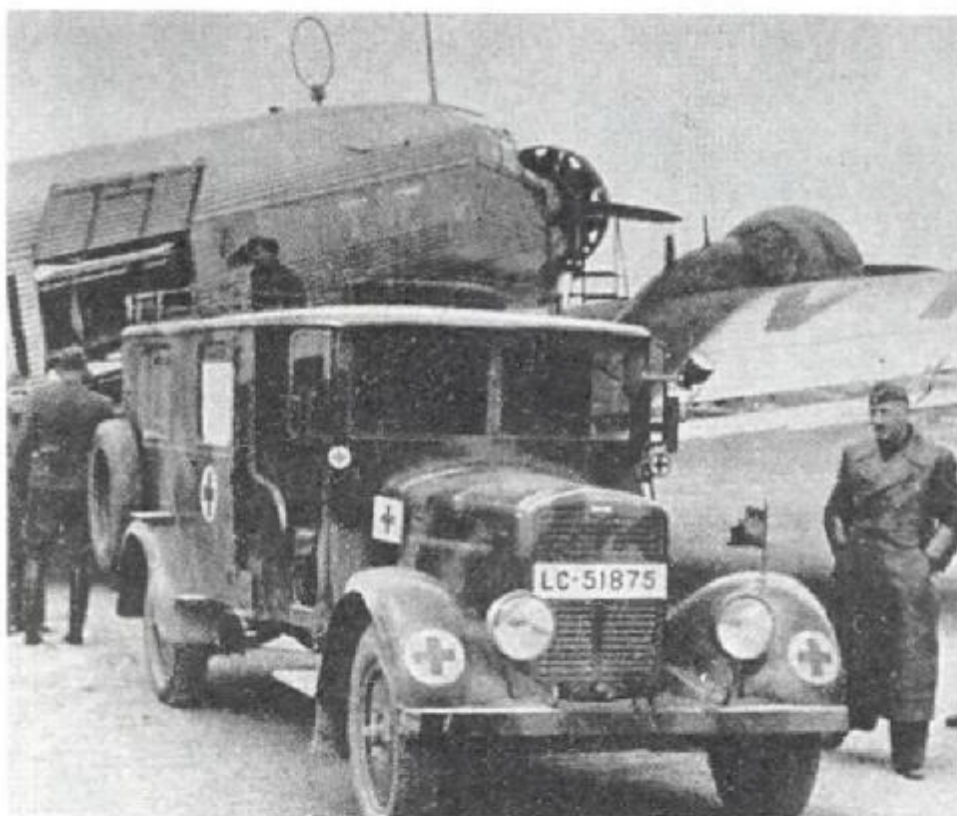
Первые санитарные машины, которые поставляла в вермахт фирма «Феномен», имели закрытое сверху, но полностью открытое с обеих сторон сиденье водителя, как у кубельвагена. На фотографии показан автомобиль, который использовался в легионе «Кондор» во время гражданской войны в Испании.
