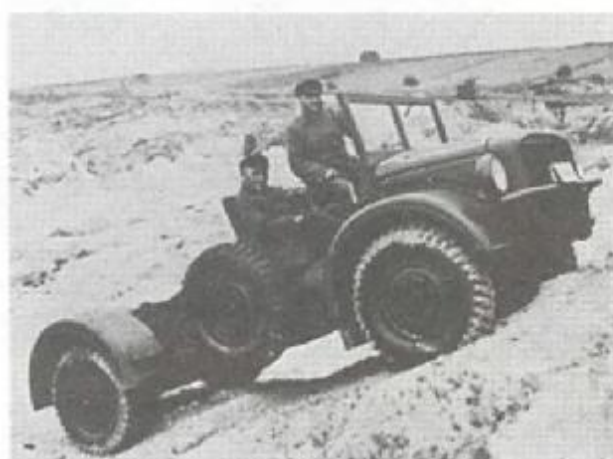
Шасси тяжелого военного легкового автомобиля: ходовые испытания при движении по пересеченной местности модели «Хорх» в окрестностях Цвиккау.
