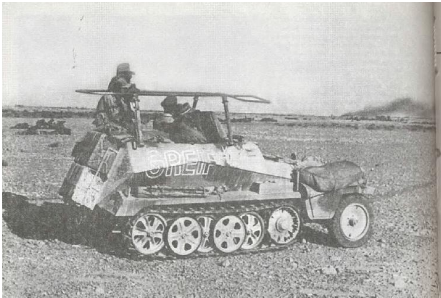
Другим штабным автомобилем, которым пользовался в Африке генерал-фельдмаршал Роммель, был этот легкий бронетранспортер радиосвязи, Sd Kfz 250/3.
