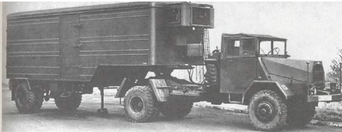
Седелный тягач повышенной проходимости 5 т MAN 630 L 2 A с кузовом-холодильником
