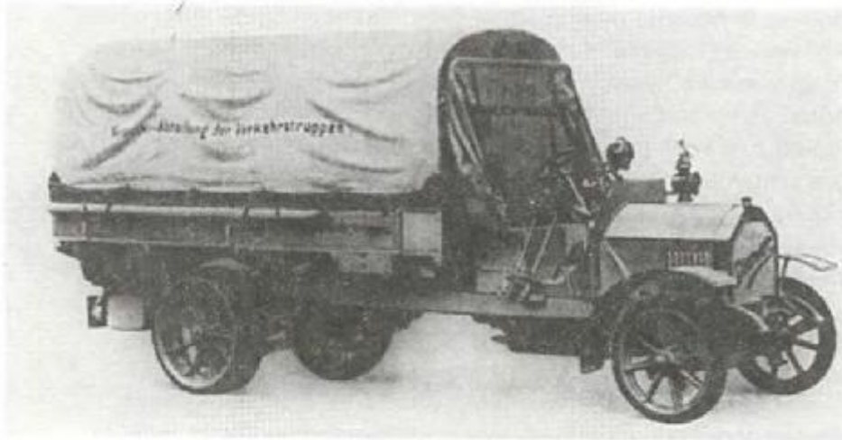
Грузовой автомобиль «Штёвер» 1907 г. Четырехцилиндровый двигатель мощностью 32 л. с., цепная передача, собственный вес 4 т, полезная нагрузка 4 т.
