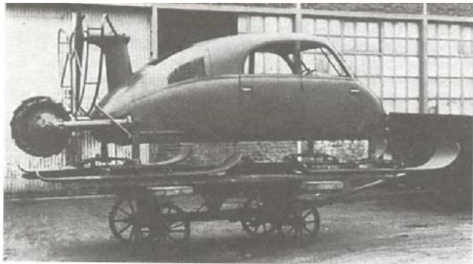
«Татра» V 855 – это аэросани, которые в 1942 г. выпускал завод «Татра» с использованием двигателя T 87. Насколько известно, сохранился лишь один-единственный прототип их, который и до сегодняшнего дня стоит в тамошнем заводском музее.
