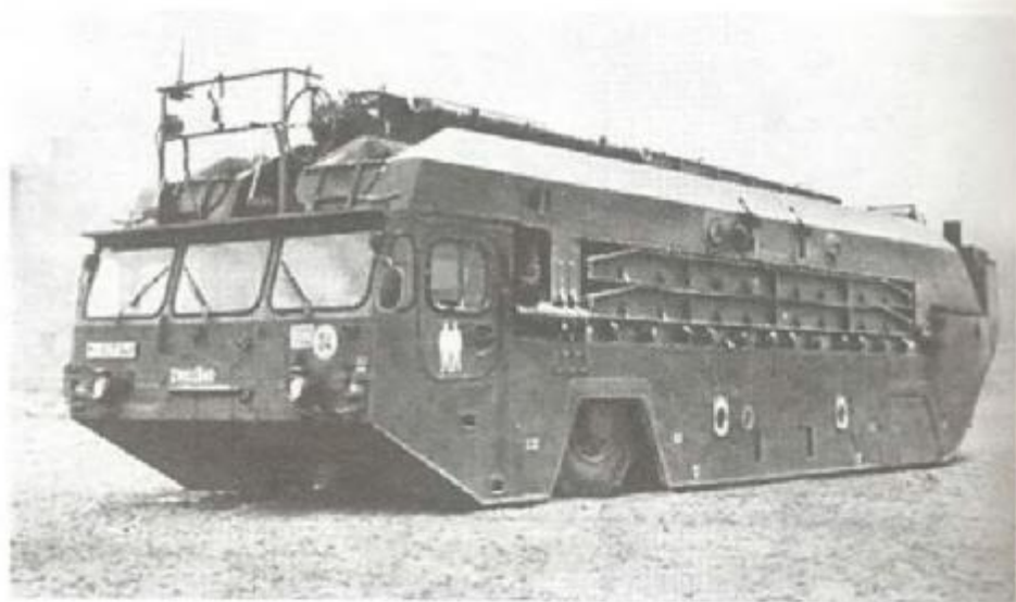
Автомобиль-амфибия модели М-2 для наводки мостов и переправ
