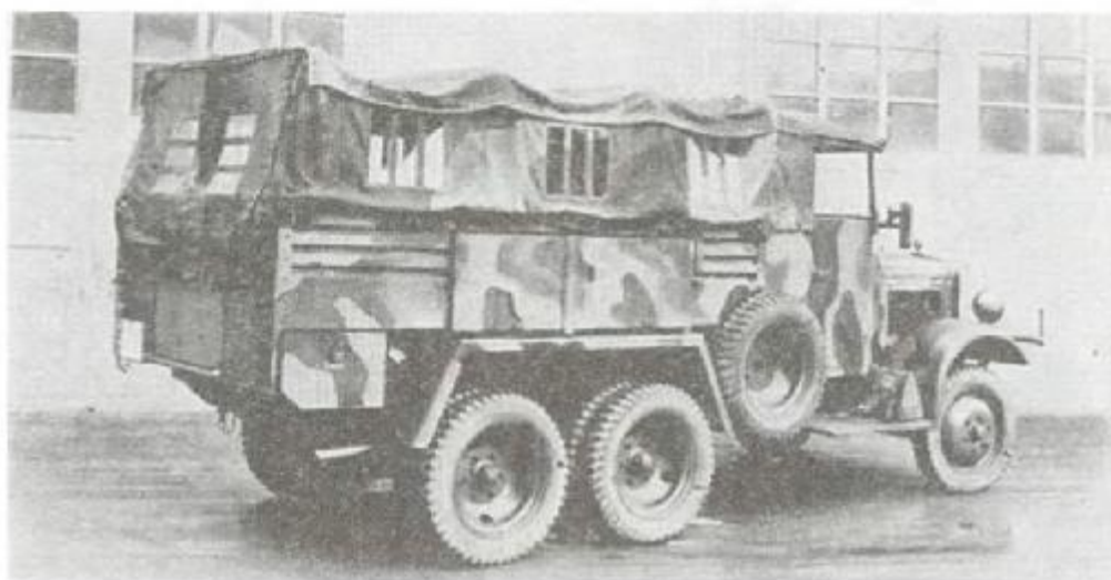
«Магирус» М 206 – легкий грузовой автомобиль повышенной проходимости грузоподъемностью 1,5 т
