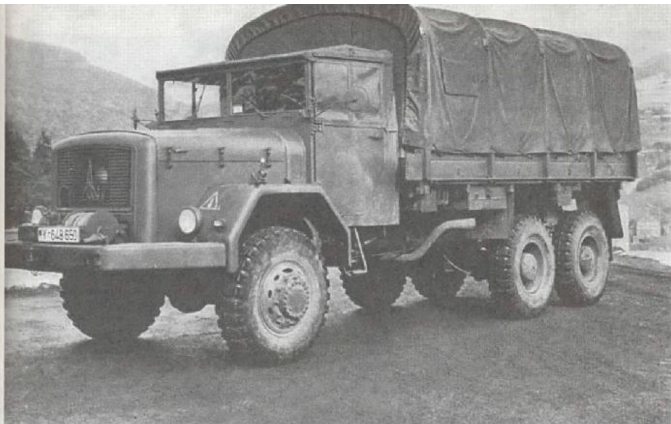
Грузовой автомобиль 7 т «Магирус-Дойц Юпитер» с лебедкой перед капотом
