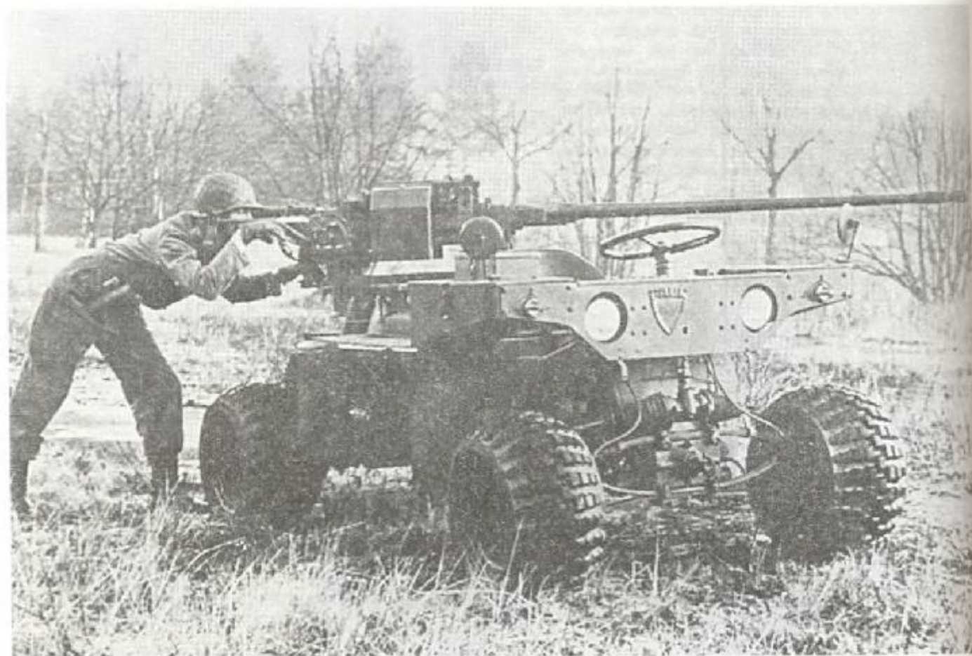
Грузовой автокар с автоматической пушкой Rh 202 калибра 20 мм
