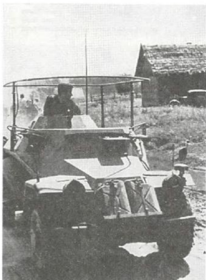
Бронеавтомобиль радиосвязи малого класса Sd Kfz 260 с рамочной антенной.
