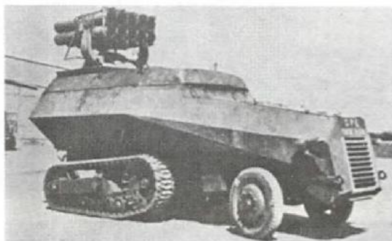
Десятиствольная установка для стрельбы 150-мм РС на трофейном БТР SOMUA (Франция). Такие переделки производились для того, чтобы максимально использовать имеющиеся трофейные материалы. Однако все они носили вспомогательный характер.
