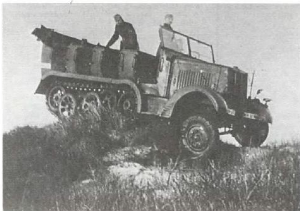
Первая серийная конструкция автомобиля-тягача с силой тяги 5 т «Бюссинг-NAG» BN L 5 (год выпуска 1935), характерные признаки: короткий гусеничный движитель и почти вертикальный радиатор, в качестве учебного автомобиля саперного учебного батальона «Дессау-Россблау» (фото 1939 г.).
