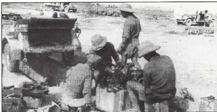
Полевая мастерская, Северная Африка, июль 1942 года. Хорошо виден частично разобранный двигатель кубельвагена.
