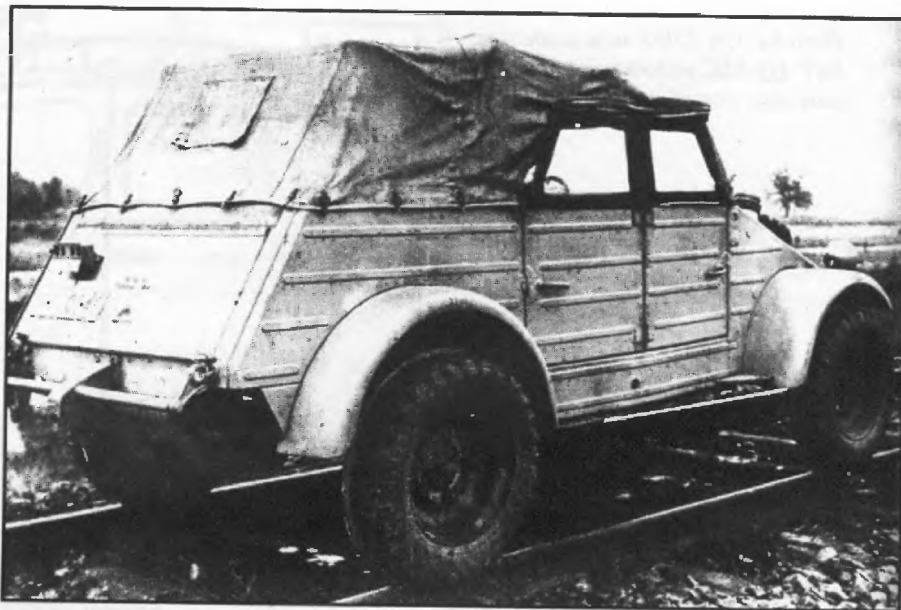
Кюбельваген, приспособленный для езды по рельсам (Тип 157).
