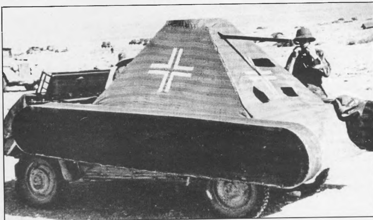
Весной 1941 года в Африку прибыли первые немецкие части. Однако силы немцев еще были явно недостаточны, чтобы противостоять англичанам. На фотографии изображен VW 82 с деревянным кузовом, имитирующим легкий командирский танк. При помощи такой бутафории Роммель надеялся пустить пыль в глаза противника.
