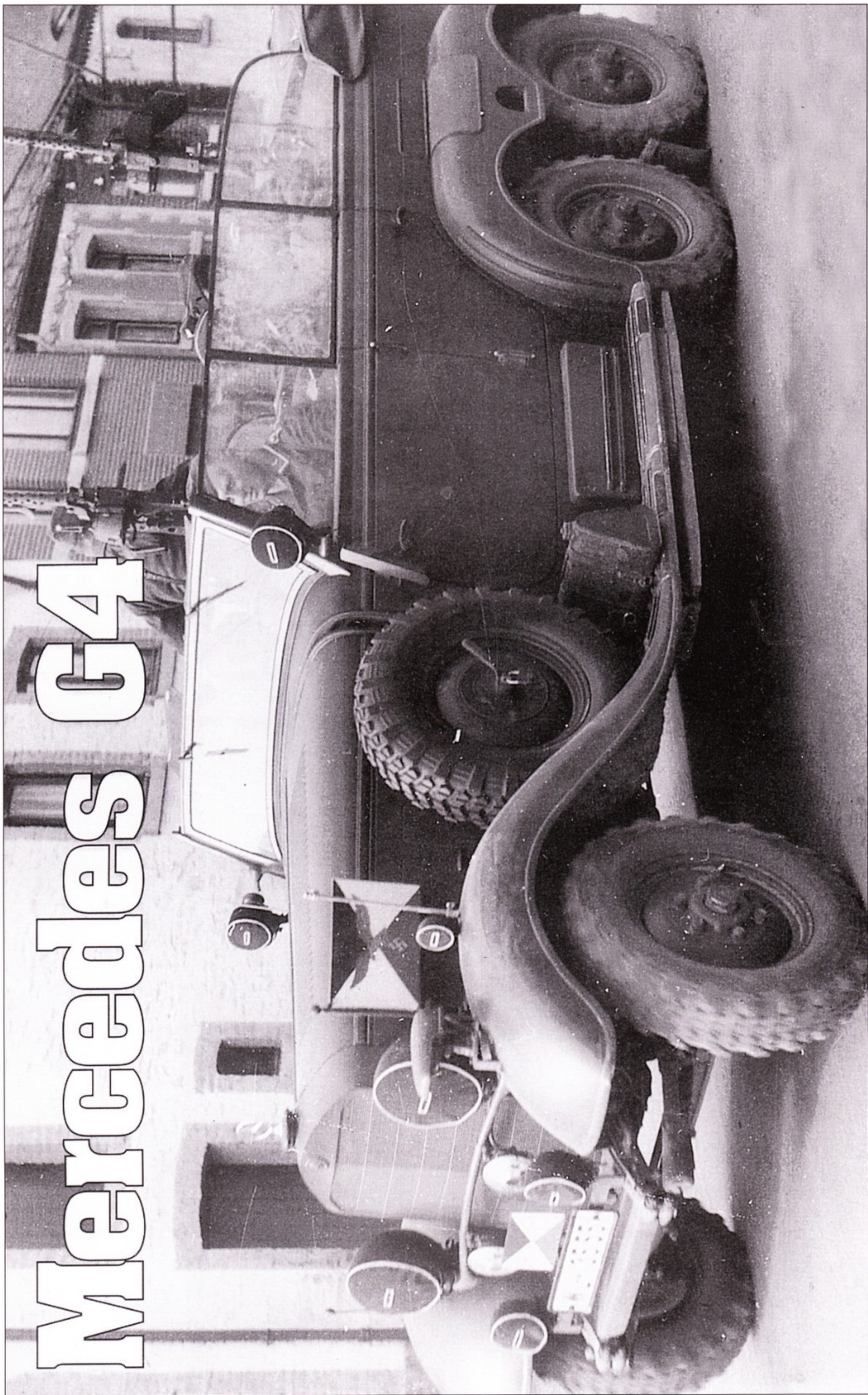
Автомобиль G4, Франция, весна 1940 г. Машина принадлежит высокому чину из командования люфтваффе. Автомобиль окрашен матовой краской, на фары установлены светомаскировочные чехлы. Зато клаксоны - хромированные!
