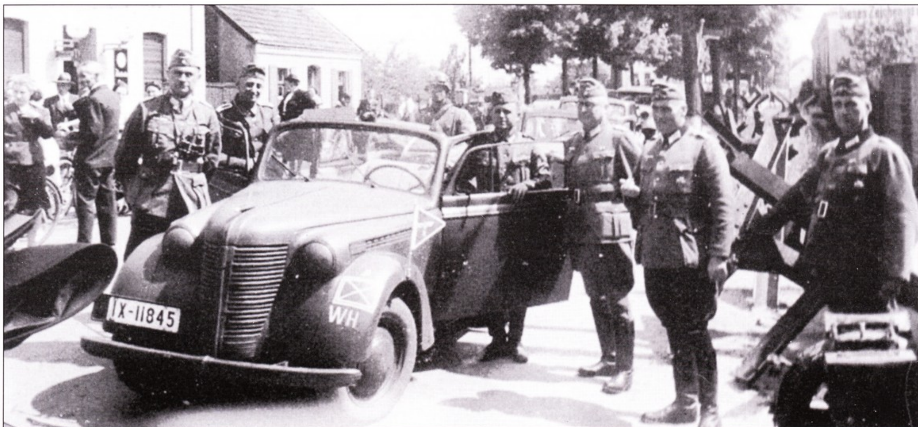
Opel «Олимпия» - первый в мире серийный автомобиль с несущим стальным кузовом. На машине стоял 4-цилиндровый двигатель мощностью 37 л.с. Серийно эти автомобили строились в 1935 - 1940 г.г. На фото - машина постройки 1938 - 1940 г.г. с кузовом кабрио-лимузин.
