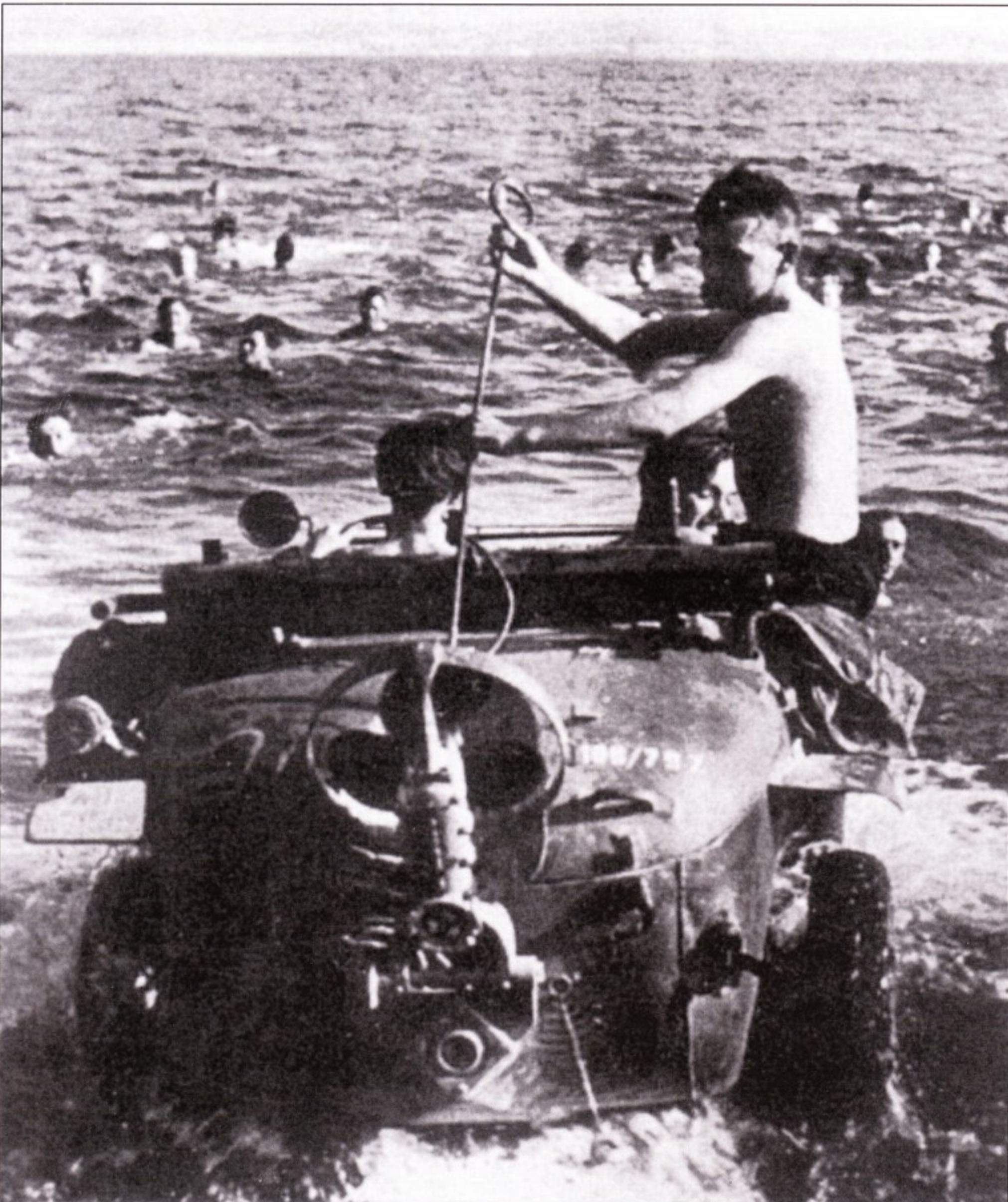
Ie.Pkw-K2 Тур 166 «Schwimmwagen», Италия, 1944 года, подготовка к опусканию винта.
