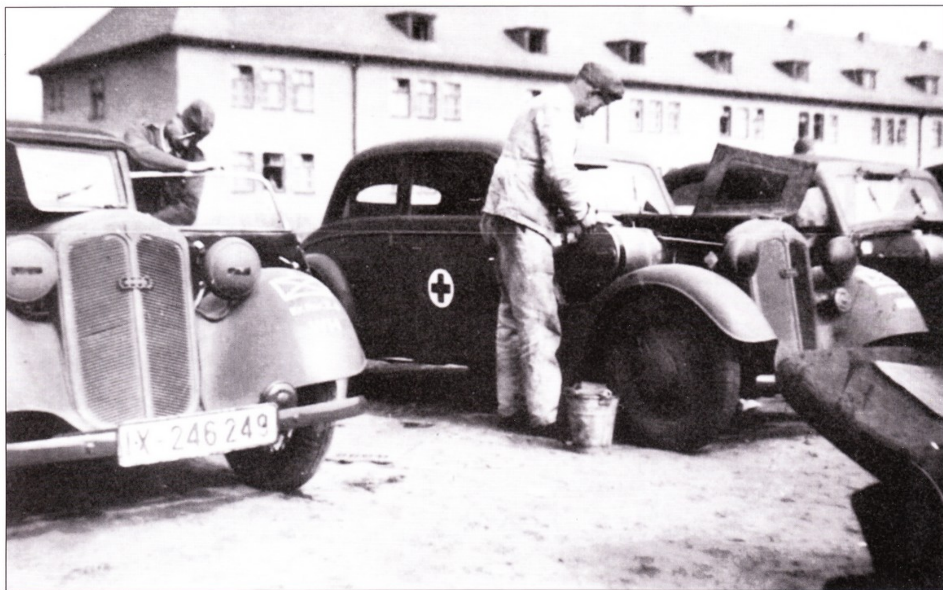
Двухцилиндровые двигатели использовались довольно широко, но вот определить на каких машинах они стояли - та еще проблема. На фото - DKW Рейхскласс (2 цилиндра объемом 0,6 л, мощность 18 л.с.) или Мастеркласс (2 цилиндра объемом 0,7 л, мощность 20 л.с.). На крайнем левом автомобиле дворники ветрового стекла закреплены вверху, как на машинах поздней постройки. Можно рассмотреть бензобак цилиндрической формы, установленный рядом с мотором. Маркировка - 2-й взвод, регистрация - Вестфалия.
