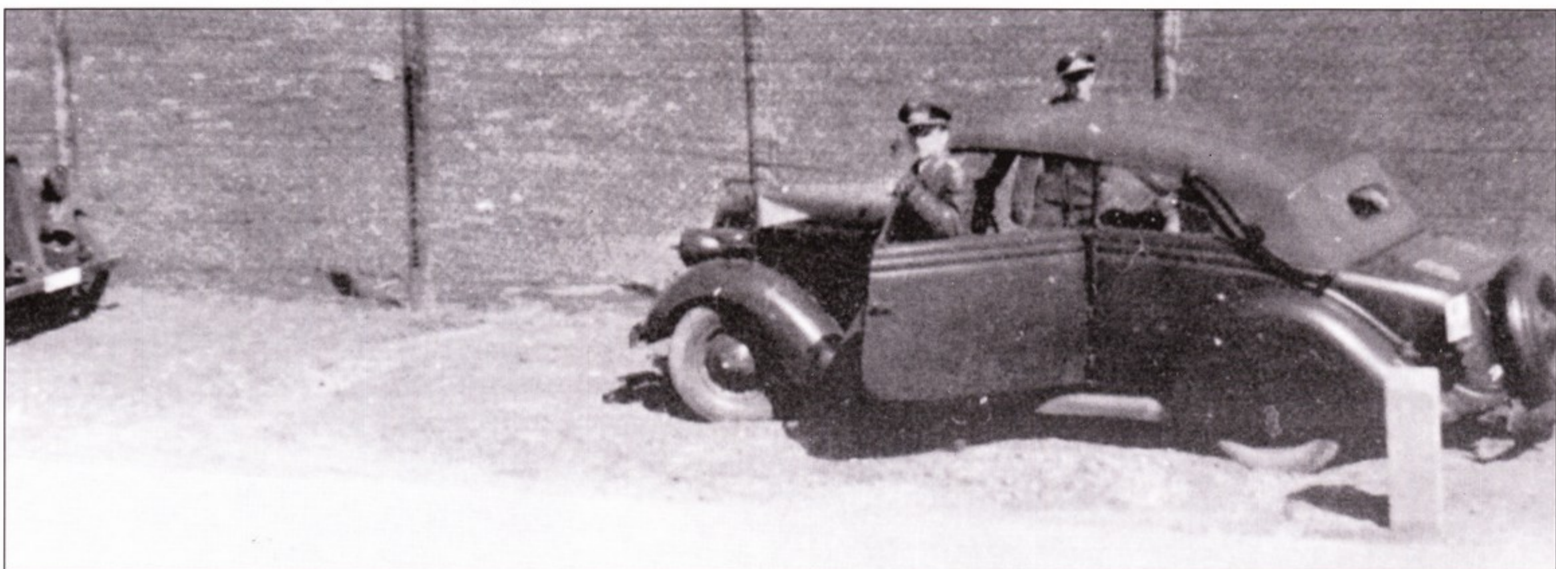
На базе автомобиля Форд V-8 было выполнено немало конверсий, например - радиомашин. На фото - Форд, переделанный в тягач 20-мм зенитной пушки Flak-38. Конверсия выполнена силами фирмы Паплер из Колона.
