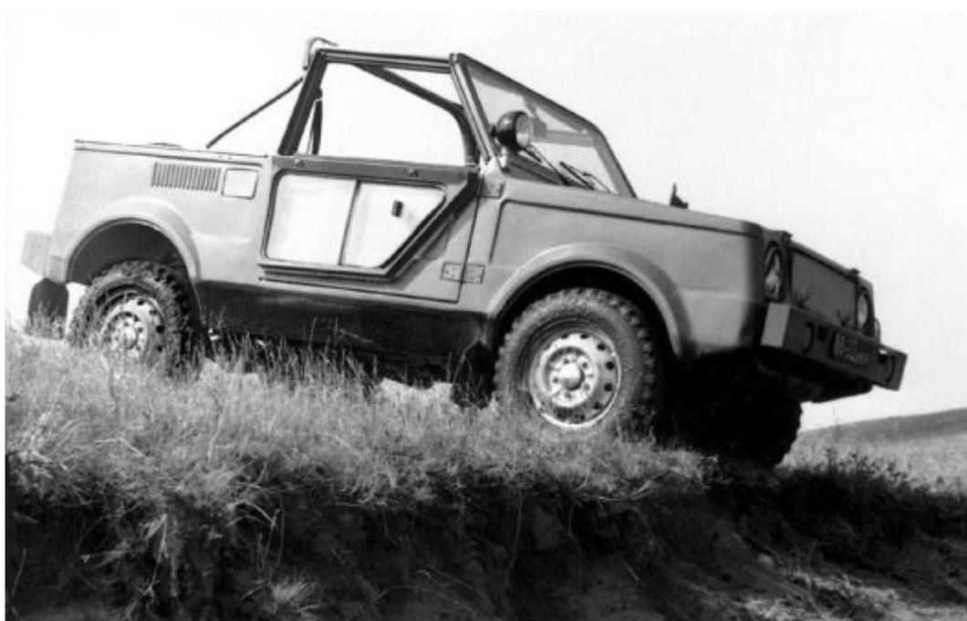
*Образец третьей серии перед плавом. Передний воздухозаборник закрыт перекидной заслонкой.*
