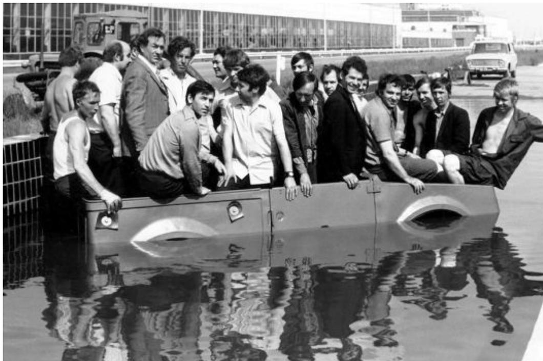
*Проверка первого кузова амфибии на герметичность в глубоководной ванне трека ВАЗа (весна 1976 г.)*
