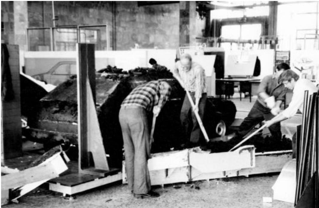
*Идёт изготовление полномасштабного макета (как раз готовится очередная порция разогретого пластилина).*
