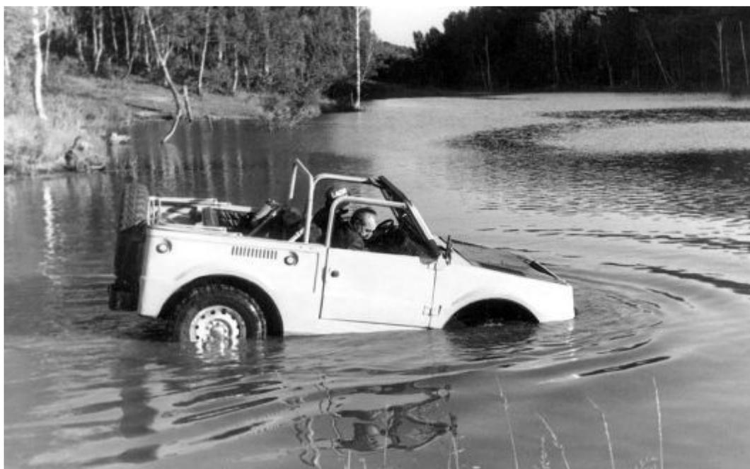
*На водоёме НИИ-21 был произведён эксперимент плава на колёсах разного диаметра. Сначала пошла машина на «больших» колёсах ВЛИ-6, которые в очередной раз подтвердили свою высокую эффективность.*
