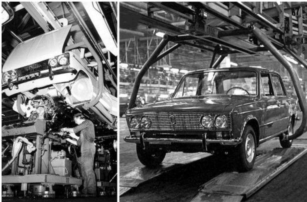
*Слева - сборка ВАЗ-2103. Справа - автомобиль сходит с конвейера.*
