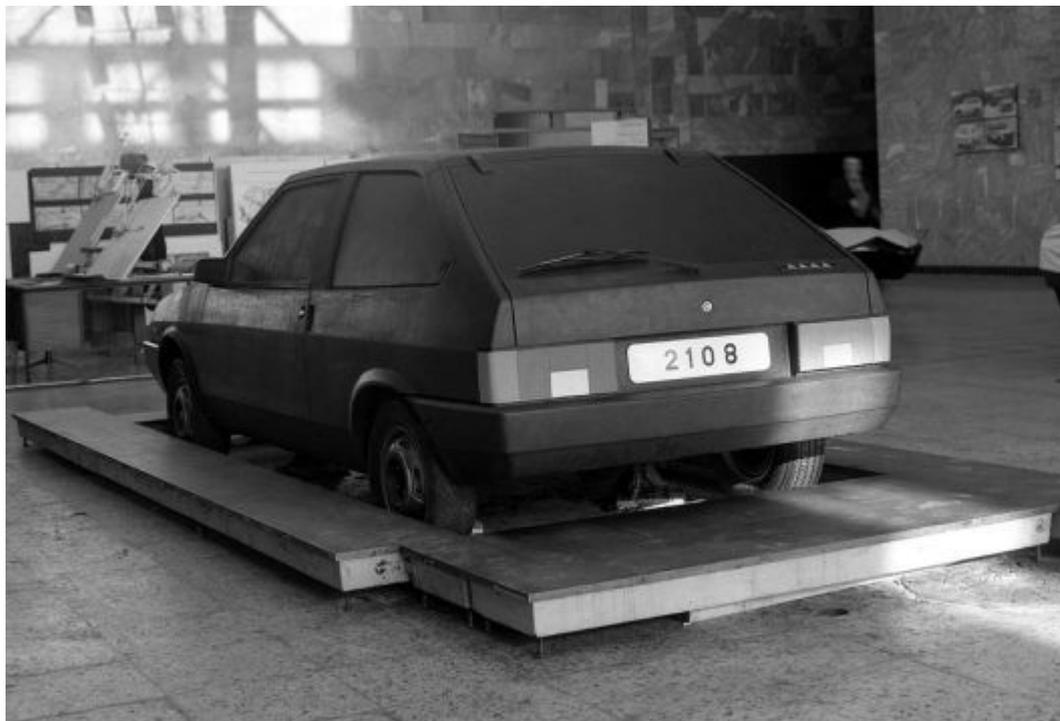
*Полноразмерный пластилиновый макет будущего массового (первого в стране) переднеприводного автомобиля ВАЗ-2108.*
