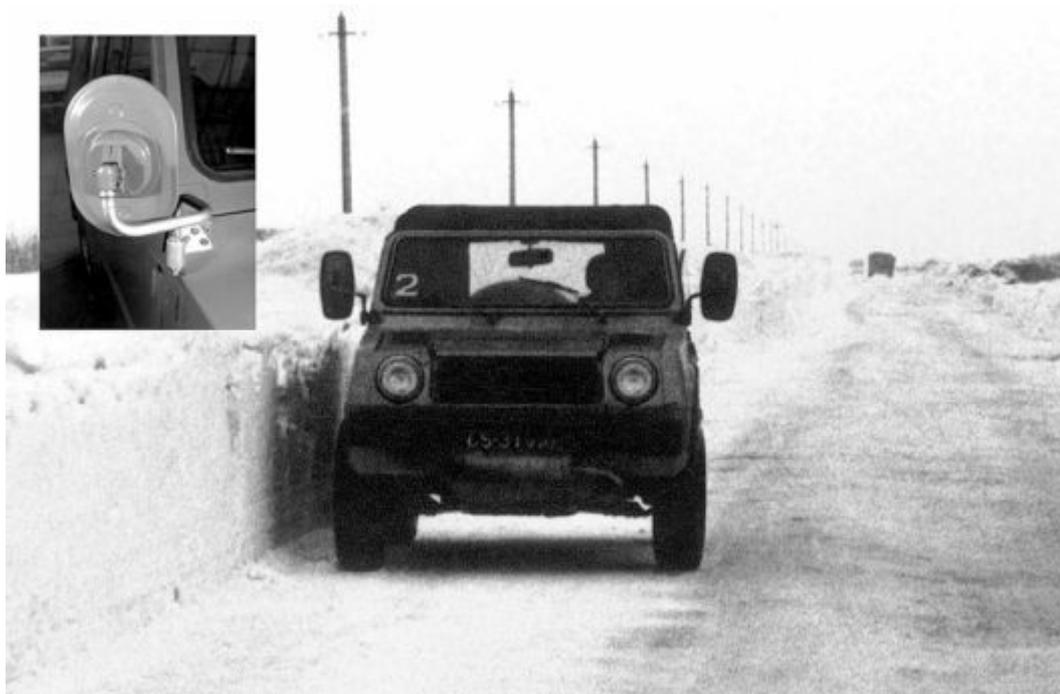
*«Ушастик» на дороге. Оба боковых «трюмо» настолько перекрывали водителю передне-боковой сектор обзора, что там мог запросто спрятаться грузовик (сравните с установленными позже зеркалом от ГАЗ-53 - вверху слева).*
