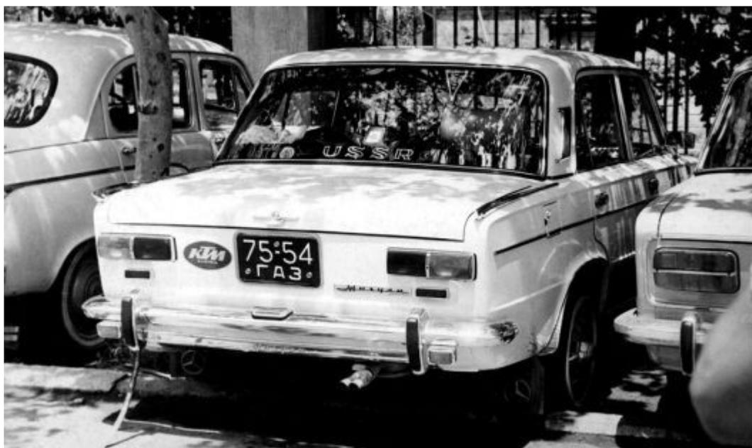
*Грузинский вариант «тюнинга» ВАЗ-2101 (1974 год, Тбилиси). Сверкающая вставка под бампером, боковые молдинги от ВАЗ-2103, хромированные законцовки задних крыльев от «Волги» ГАЗ-21. Абсолютно бесполезные накладки на задних стойках от ГАЗ-24 (вытяжной вентиляции тогда ещё и в помине не было). Более нелепую мешанину представить трудно, но хозяин, похоже, такой «эксклюзивной» машиной очень гордился.*
