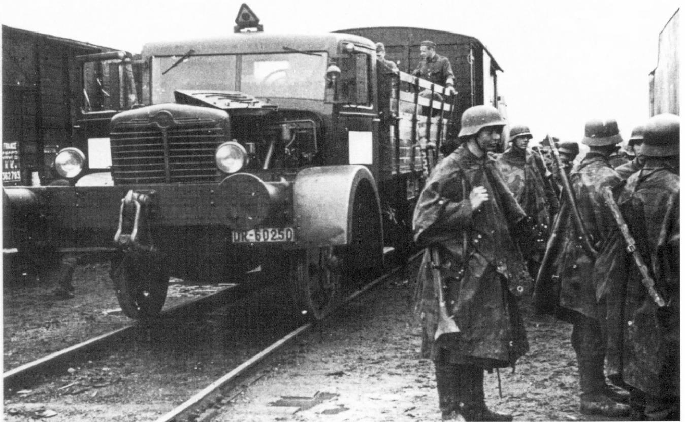
Schienengängige Kfz. konnten per Straße gesprengte Schienenstrecken umgehen und waren nach Austausch der Räder und Anbau einer Pufferbrust als „Lokomotive“ einsatzbereit. Hier ein **Büssing - NAG Typ 500 S** der Reichsbahn. Die Soldaten haben sich die Zeltbahn umgehängt; links ein MG 34, rechts der Behälter für den Ersatzlauf.
