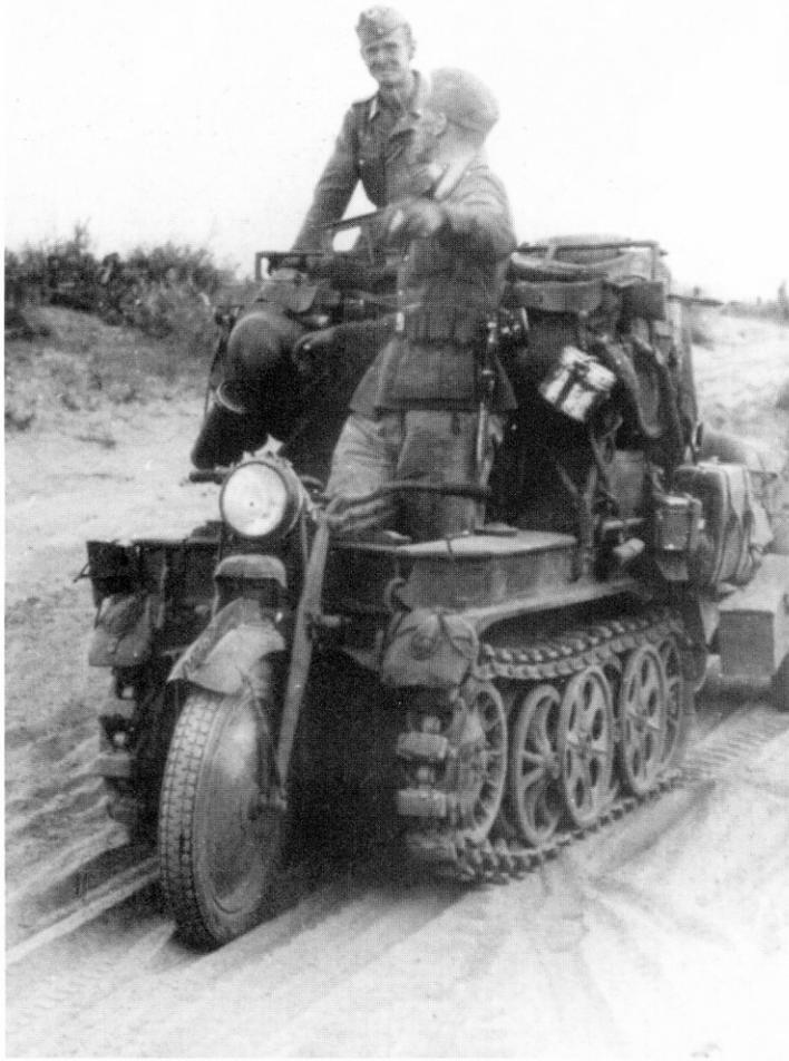
*Kleines Kettenkraftrad für Feldfern kabel (Sd.Kfz.2/1) dieses schmalspurige Fahrzeug wurde durch den hohen Aufbau natürlich recht kippelig. Bei späteren Fertigungen wurde auf den Scheinwerfer verzichtet. Welcher Leser hat die Fotos vom **großen Kettenkraftrad** mit seinen unglaublichen Versionen?*
