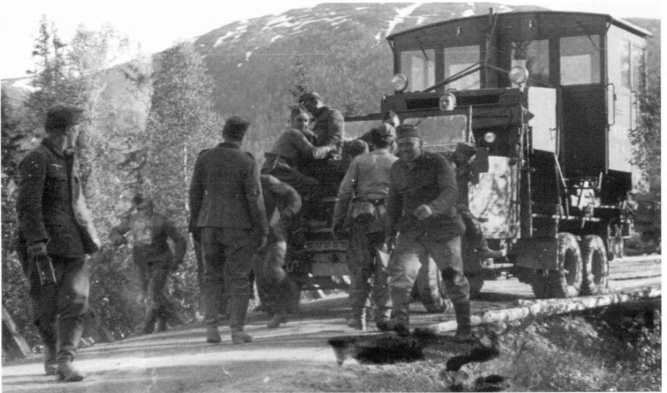
Abtransport einer norwegischen Diesellokomotive durch Angehörige der 5./ Eis.Pi. Regt. 3. Der **Henschel Typ 33** war als **m.gl.Lkw.off.(o)** für eine Nutzlast von 3 to ausgelegt. Der Wagen im Bild ist reichlich hecklastig beladen, so daß einige gutgelaunte Pioniere die Frontpartie belasten müssen.
