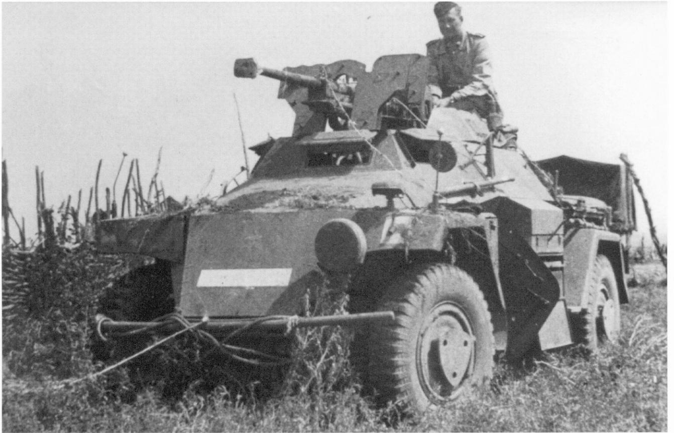
Südrußland, 1942. Vom **leichten Panzerspähwagen (Sd.Kfz.221)** wurden bis Mai 1940 339 Einheiten gebaut. Ab 1942 wurden die verbliebenen Fahrzeuge mit einer 2,8 cm schweren Panzerbüchse 41 aufgerüstet.
