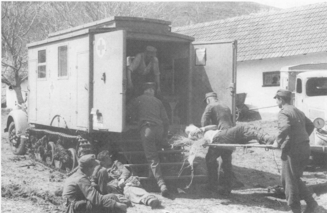
Ein Schwerverwundeter, armselig auf Stroh gebettet, wird in einen Gleisketten-Sanka eingeladen (Ukraine 1944). Ein Opel (am Vorderrad erkennbar) „Maultier“ mit Einheits-Kofferaufbau aus Pressspan. Beachte den serienmäßigen Radausschnitt, der zum Staukasten umgebaut wurde. Rechts ein Phänomen Granit 1500 als Kfz.31.
