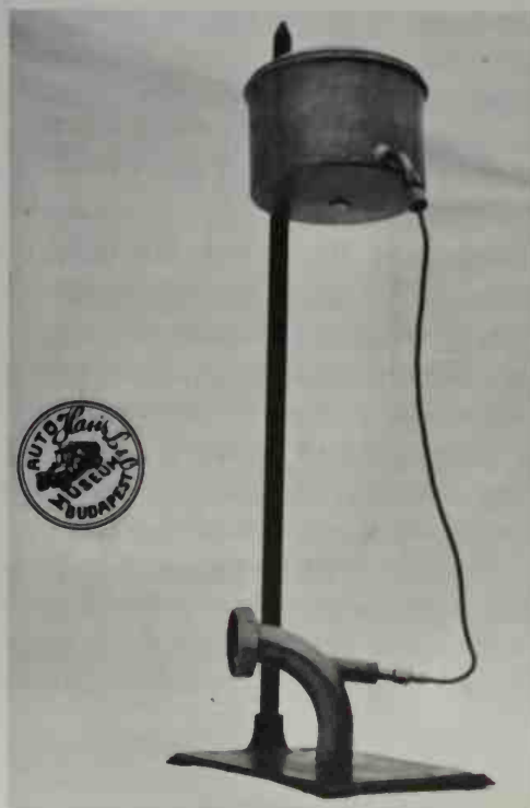
Donát Bánki and János Csonka constructed this pioneer carburetor in 1892 in Budapest. ( Haris Testvérek Autó Múzeuma )
