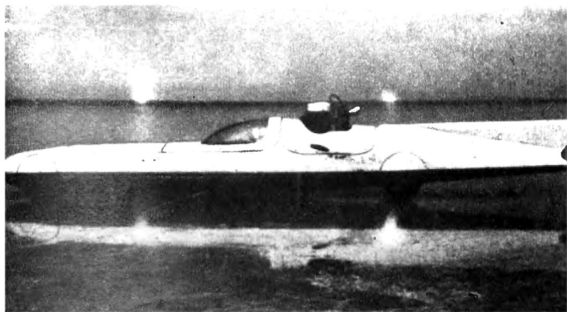
Рекордный автомобиль ХАДИ-3 с минимальной лобовой площадью
